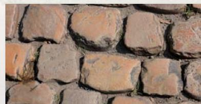
Il est possible que ces joints soient associés à une structure perméable. Ils peuvent être associés à des ouvrages connexes permettant de pallier le colmatage de la structure. Pour permettre l'infiltration des eaux de ruissellement, il est nécessaire de vérifier :
