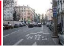
> Couloir mixte bus – vélos élargi interrompu en amont du carrefour pour créer une voie de présélection ou de stockage supplémentaire (carrefour chargé)
