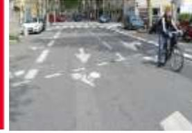
> Bande cyclable sur un axe où le **mouvement de tourne-à-droite est fort**, cas où une voie peut être créée sur le stationnement
