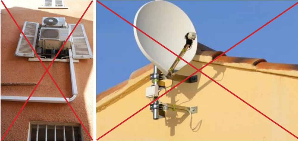
*Que ce soit en toiture ou en façade, les équipements techniques (appareils thermiques, aérauliques, machineries d'ascenseurs, de climatiseurs, antennes paraboliques, etc.), doivent être intégrés dans le bâti.*
