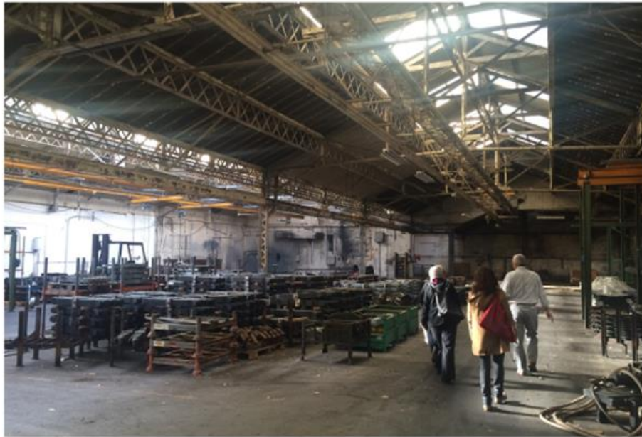
Photo de l'intérieur de la halle
