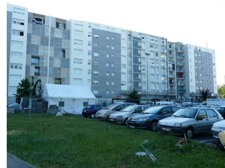
Photographie 32 : Bâtiment Malval en cours de rénovation
