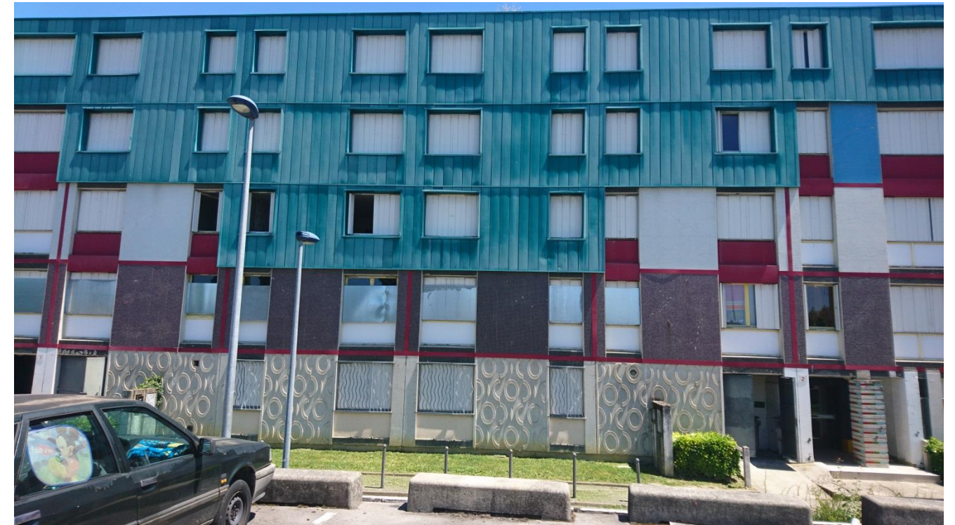
Figure 56 : Façade propice aux Chiroptères - © Egis Environnement
