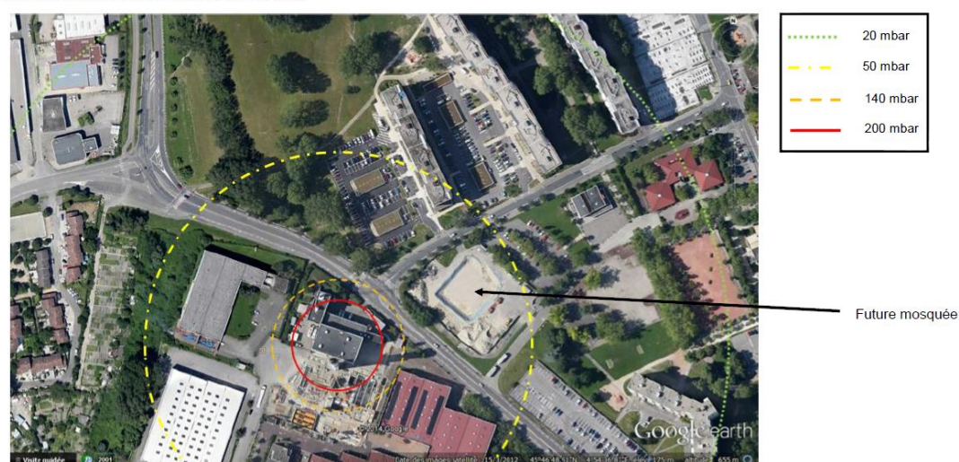
Explosion au niveau du local de la chaufferie gaz
