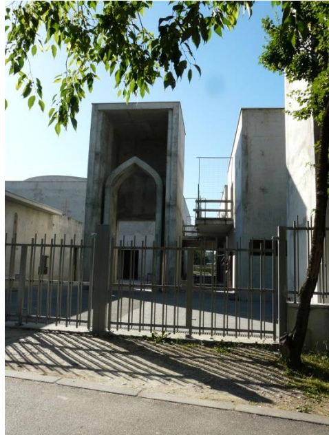
Photographie 40 : Mosquée en cours de construction
