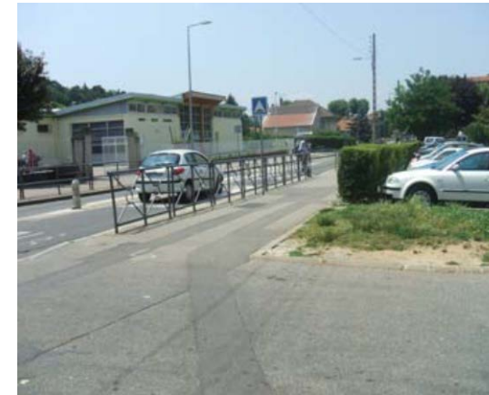
Trace de réfection de chaussée
