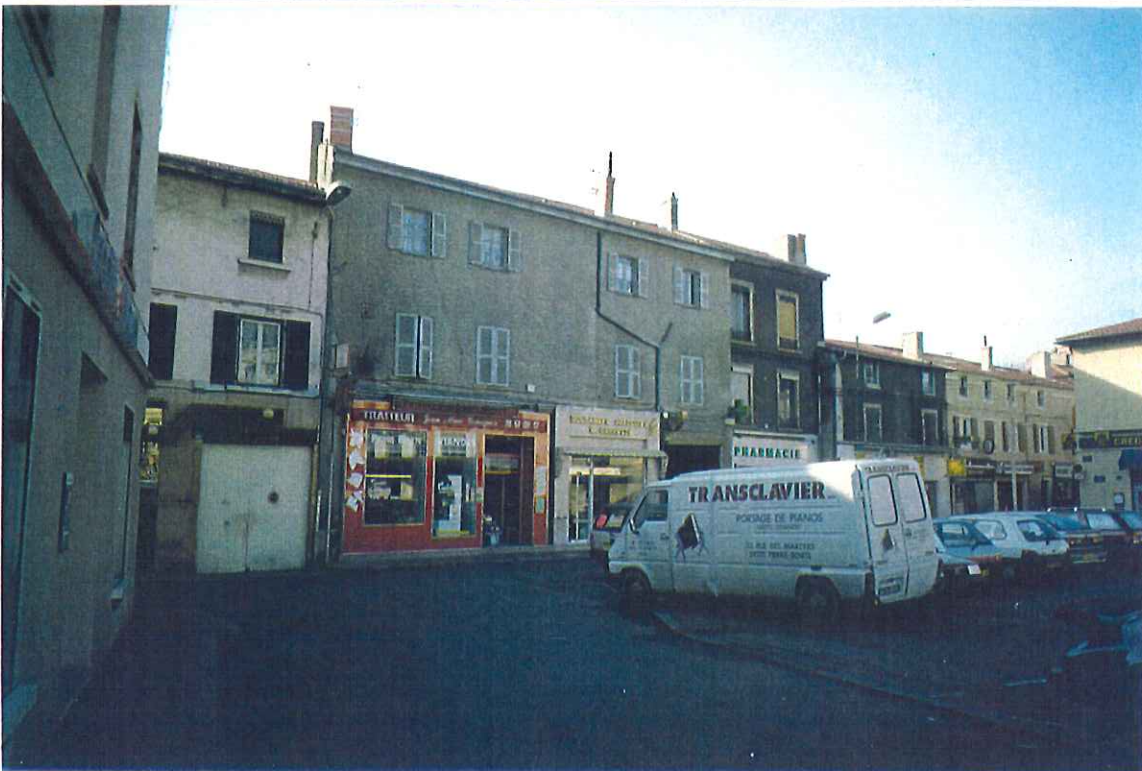
2.10 Façades de l'îlot sur la place Jean Jaurès.
