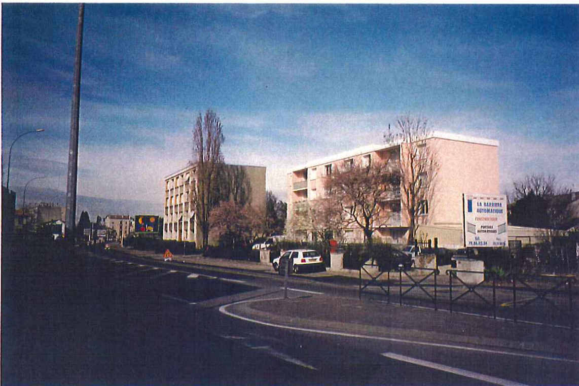
1.3 L'alignement du boulevard de l'Europe est parfois marqué par certains immeubles des années 60.
