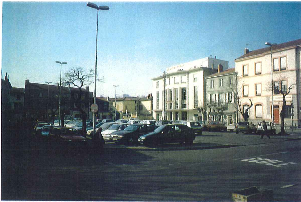
2.13 Vue sur la limite Nord de la place Jean Jaurès, avec la Maison du Peuple.
