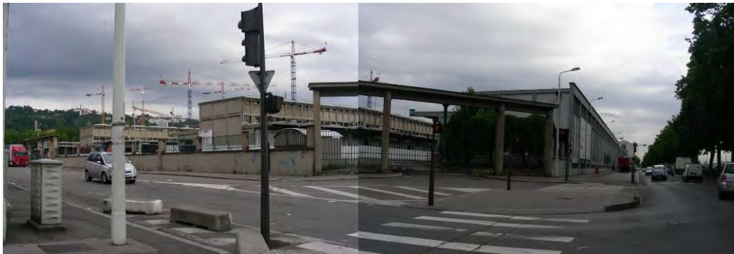
Site de l'ancien Marché de Gros
