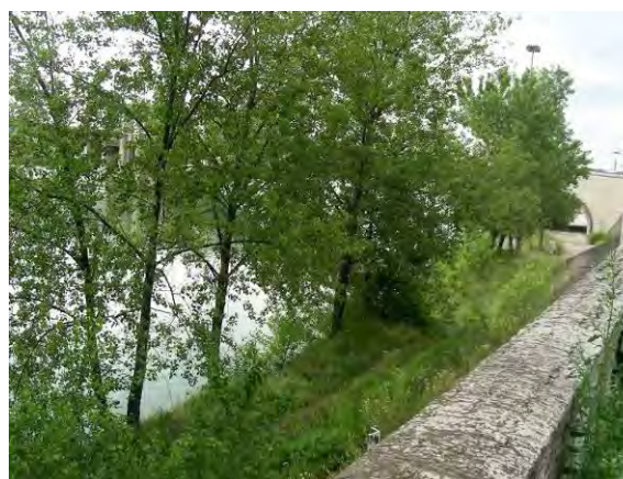
Rive droite du Rhône en amont du Pont Pasteur – Juin 2009
