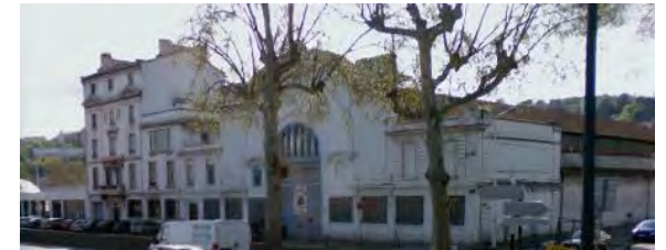
Conservation d'éléments architecturaux de bâtiments le long du quai Perrache
