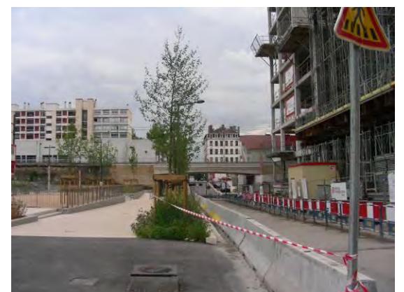
Prolongement de la rue Casimir Perrier et passage sous la voie ferrée
