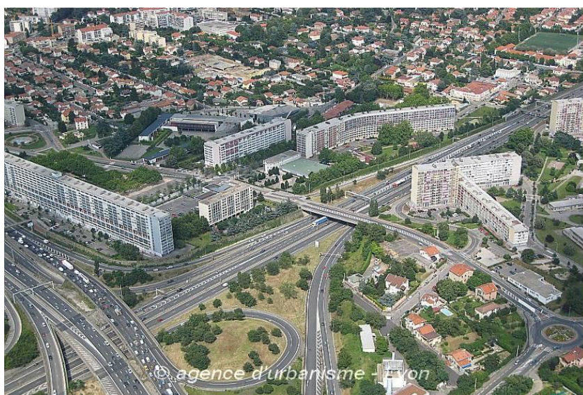
Figure 6 : Parilly après la réalisation des axes autoroutiers au milieu des années 70 (Source : Agence d'urbanisme de l'aire métropolitaine lyonnaise)
