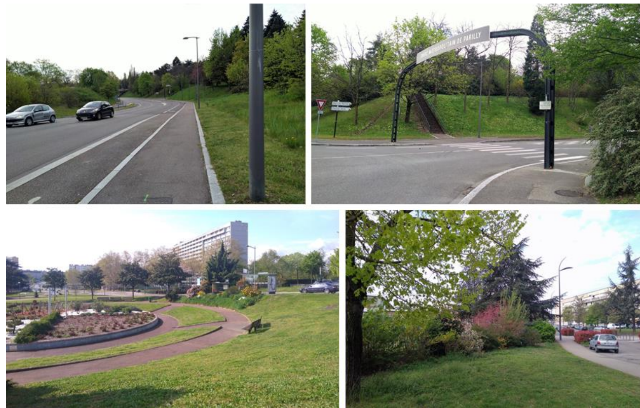
Figure 93 : rue Lionel Terray longeant le parc de Parilly et rond-point/rue E. Herriot larges et plantés, (Source : Even Conseil)
