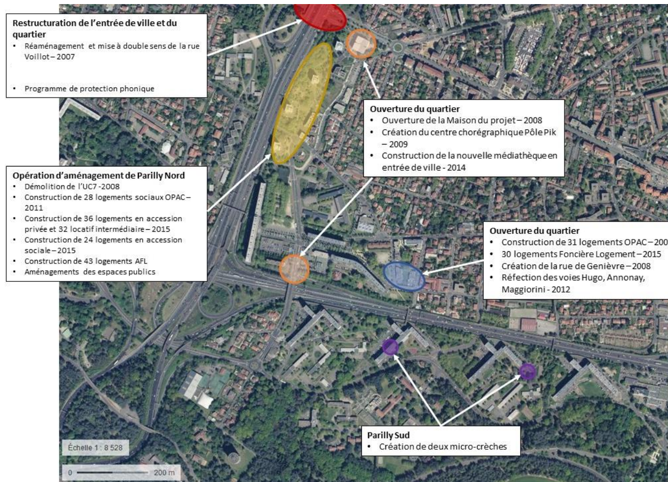
Figure 163 : Interventions réalisées dans le cadre du PNRU1
