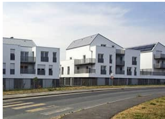
Le Plessis-Bouchard (95). Louis Téquy architecte
