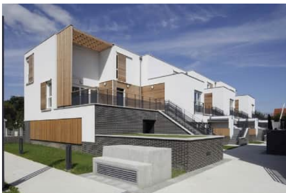
Montfermeil. Caradec & Risterucci architectes © Hervé Abbadié
