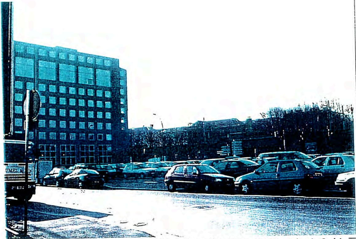
Secteur non urbanisé issu de la démolition du bâti rue Louis Guérin
