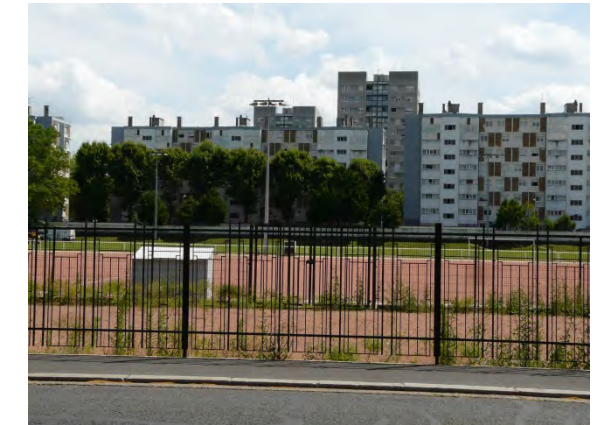
Grands collectifs de la cité Saint-Jean vus depuis le complexe sportif des Peupliers au Nord
