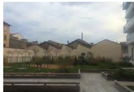
Photo de la façade ouest
