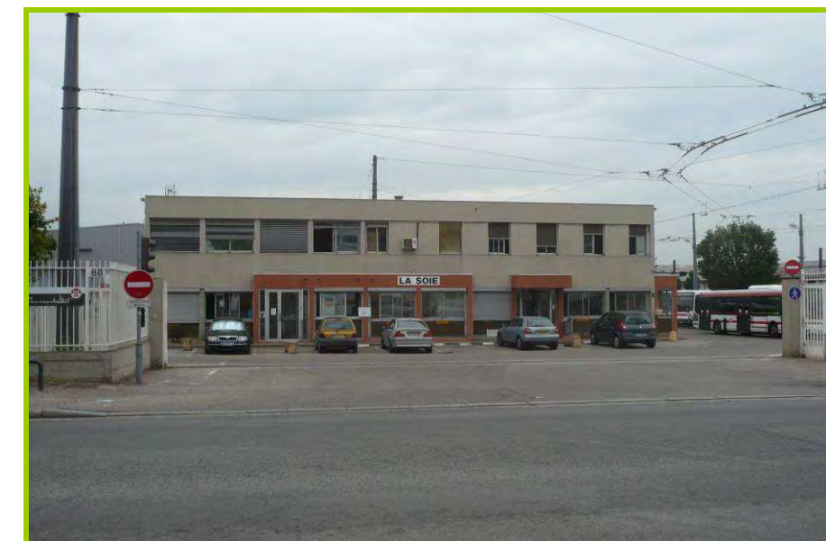
Le dépôt bus du Sytral
