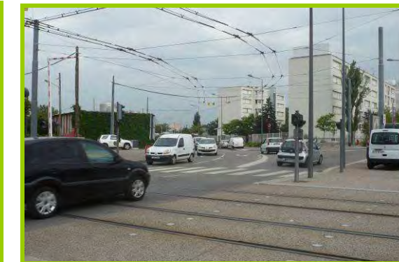
Carrefour entre l'avenue des Canuts (Vaulx-en-Velin) et la rue de la Poudrette
