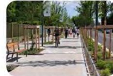
Voiries du Pôle de loisirs
