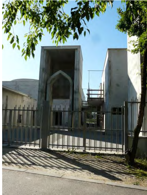
Photographie 40 : Mosquée en cours de construction
