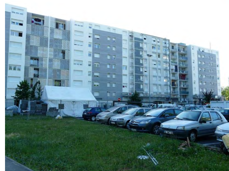
Photographie 32 : Bâtiment Malval en cours de rénovation
