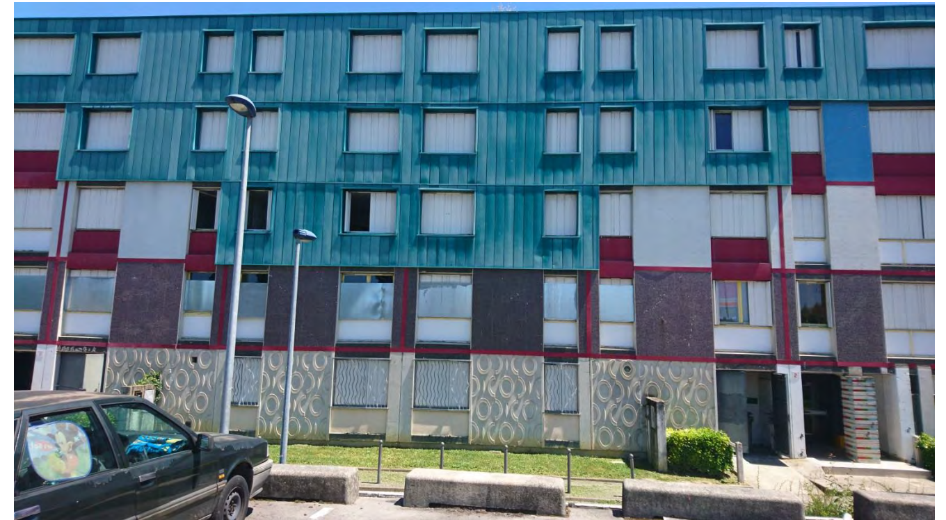
Figure 56 : Façade propice aux Chiroptères - © Egis Environnement
