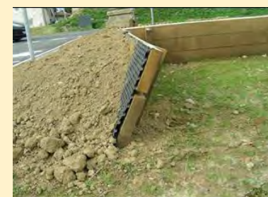
Filet de protection pour la petite faune terrestre
