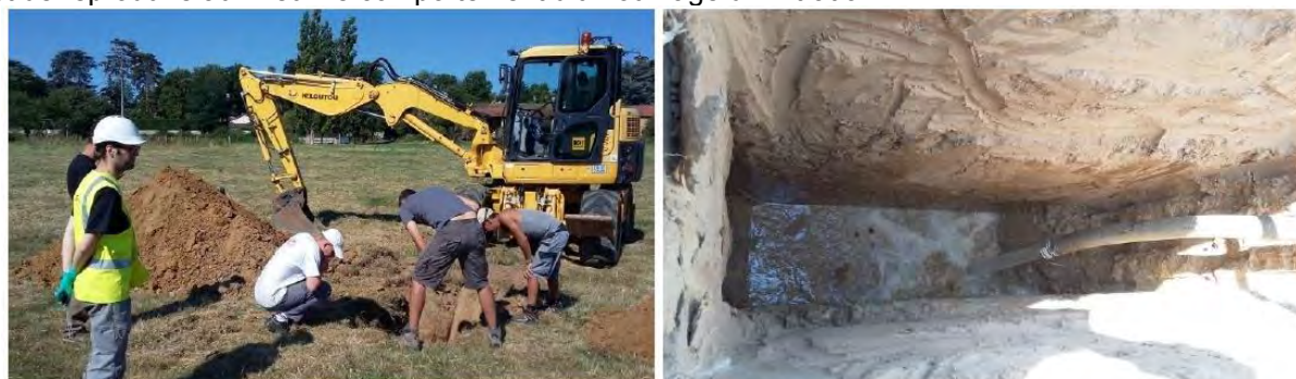
Creusement de la fouille et remplissage avant mesure (source : BURGEAP)
