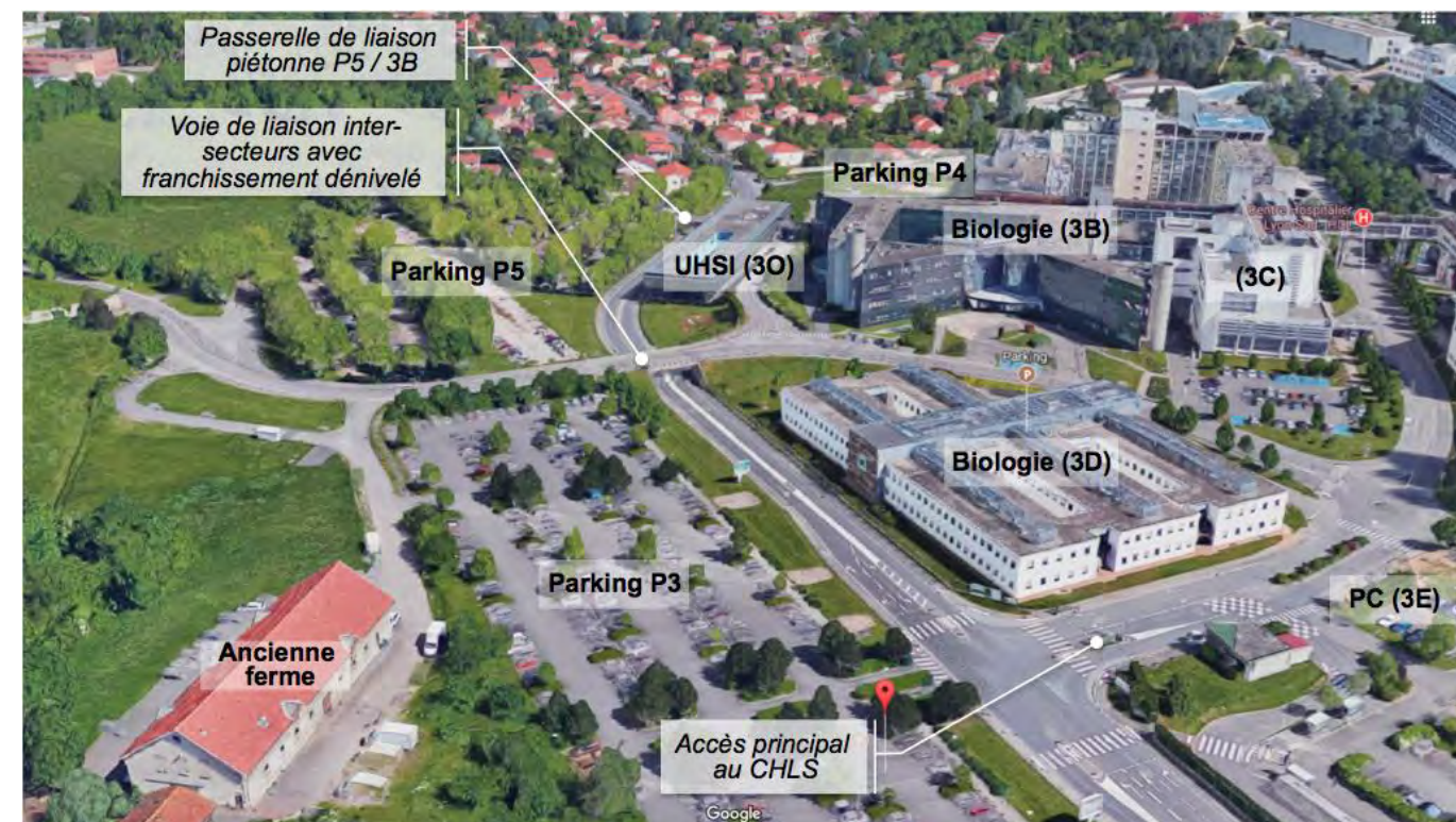
Vue aérienne du Vallon des Hôpitaux avec repérage de la voie de liaison et de l'accès principal au CHLS (vue aérienne : Google maps)
