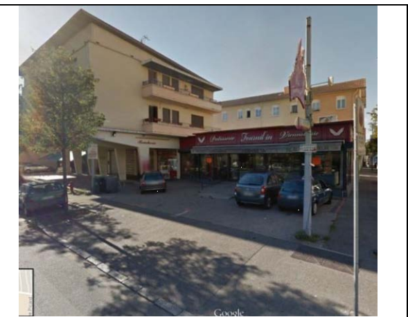
Situation actuelle du site au 53 rue Carnot, Saint Fons (ARTELIA)
