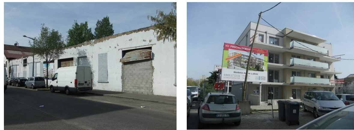
Ancien site des Tanneries Lombardet : Ilot de friche industrielle à gauche – Ilot récemment bâti à droite
