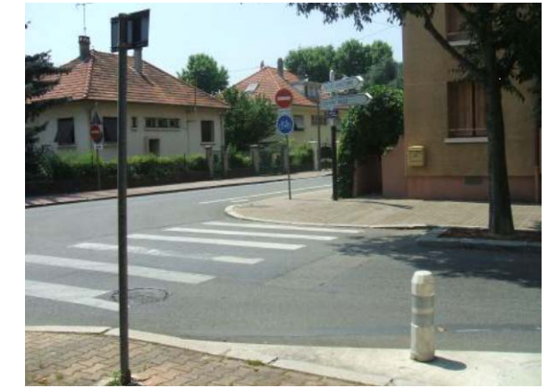
Revêtements : enrobés noirs sur chaussée et pavés sur trottoirs
