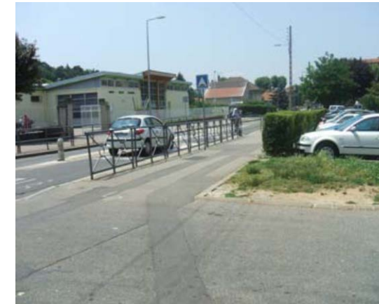
Trace de réfection de chaussée
