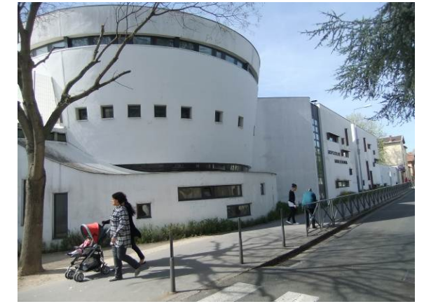
Groupe scolaire Simone de Beauvoir
