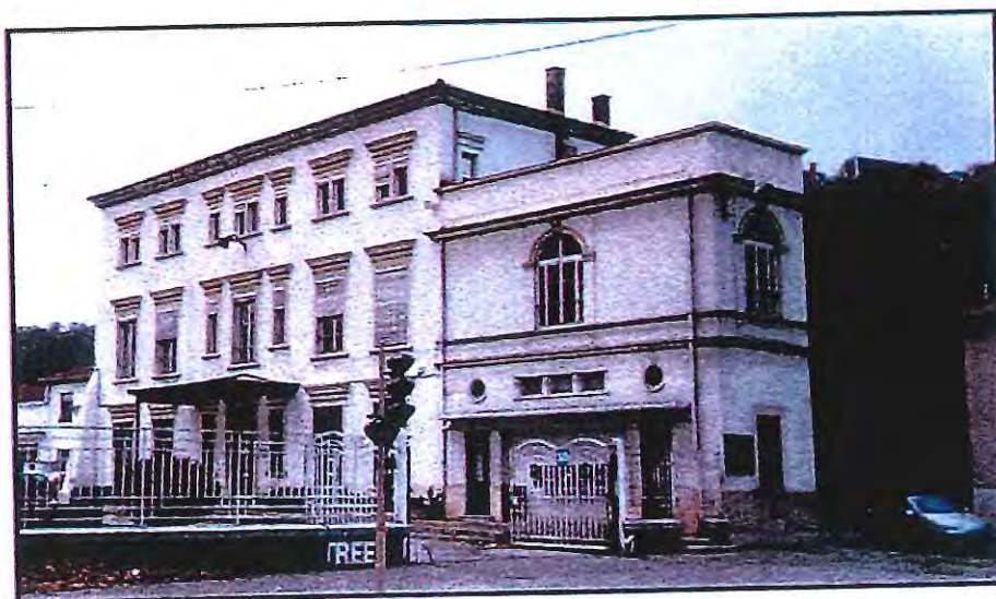
La maison de maître de Rivoire et Carret
