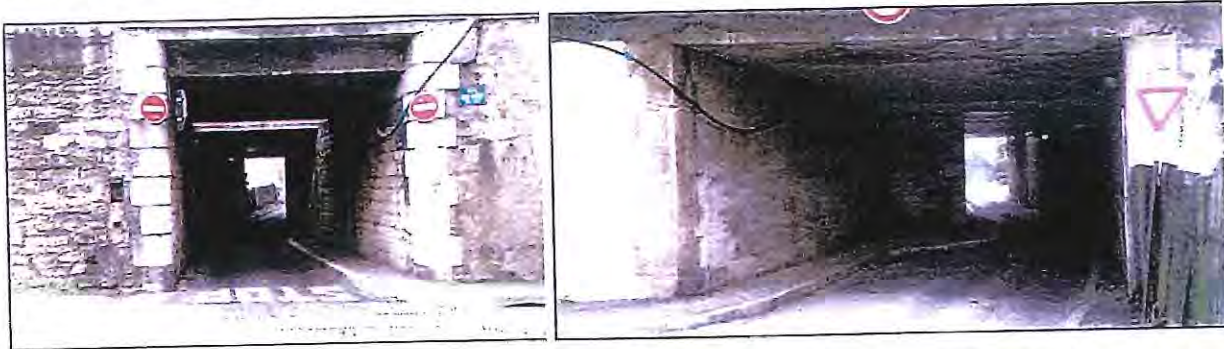
Le passage inférieur Antonin Laborde coté est puis ouest des chemins de fer
