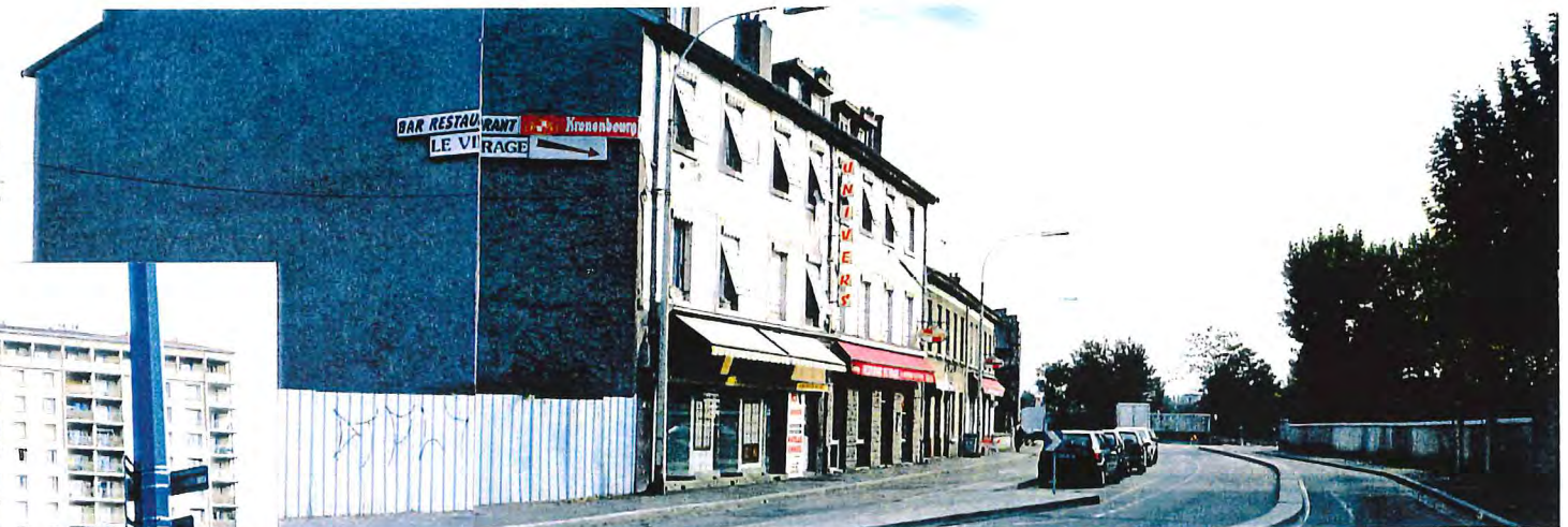
Immeubles d'habitation rue Fleming (îlot de "la Chancellerie")
