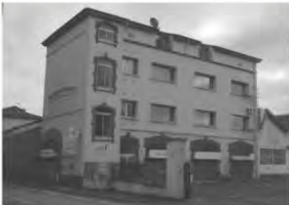
Bâtiment Jules Weitz
