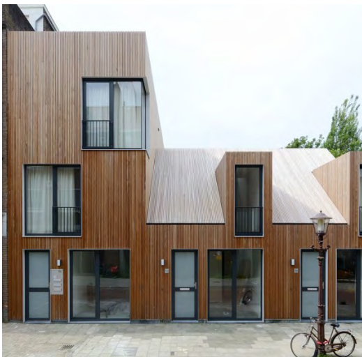
© M3H Architecten - Rythme bâti avec épannelage des hauteurs
