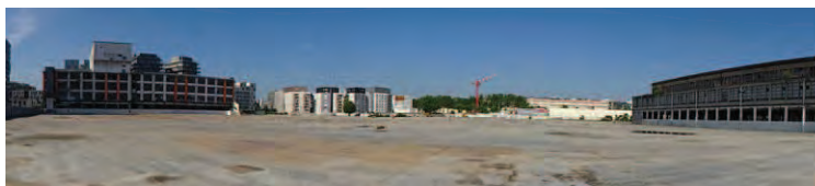
©Métropole de Lyon - 2018 (après démolitions)
