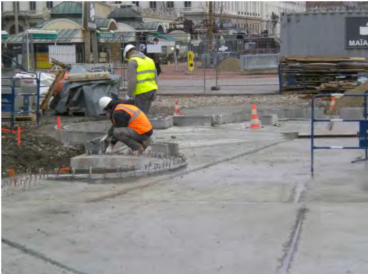
Début de la pose de parpaings pour constituer le contour du bassin (5769WM037)
