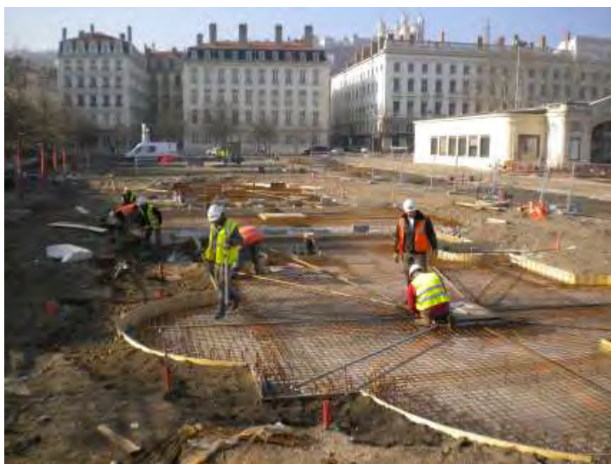
Maçonnerie des bassins, mise en place du treillis soudé en 2011 (5769WM035)
