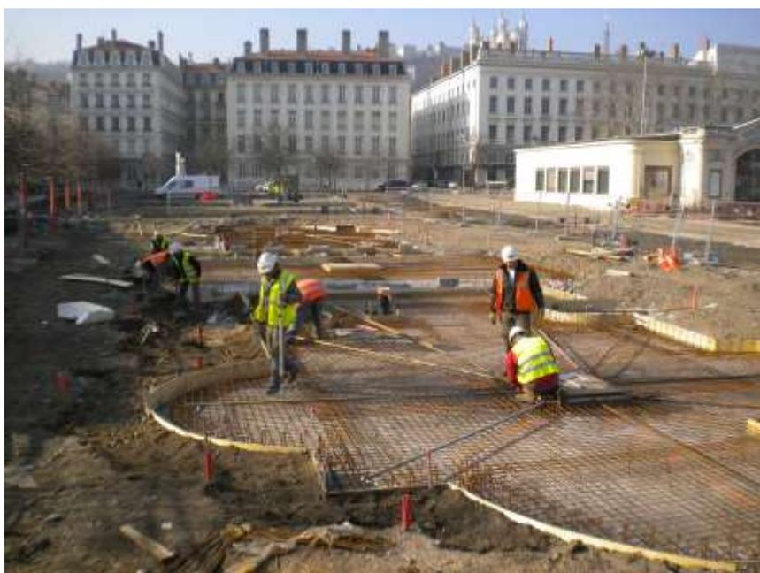
*Maçonnerie des bassins, mise en place du treillis soudé en 2011 (5769WM035)*
