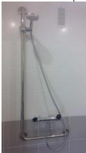
Exemple de barres d'appui (sources : LMH)
