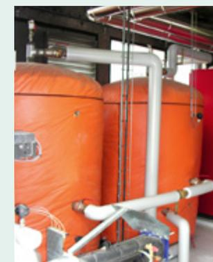
Ce calorifugeage devrait être fait avec soin (notamment au passage de chaque collier qui constitue un pont thermique) et les épaisseurs finales ne devront pas être inférieures aux valeurs suivantes :
