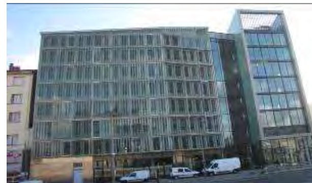
Sunway / L'Art de Construire & Domoa – 6 900 m 2 - Livré
