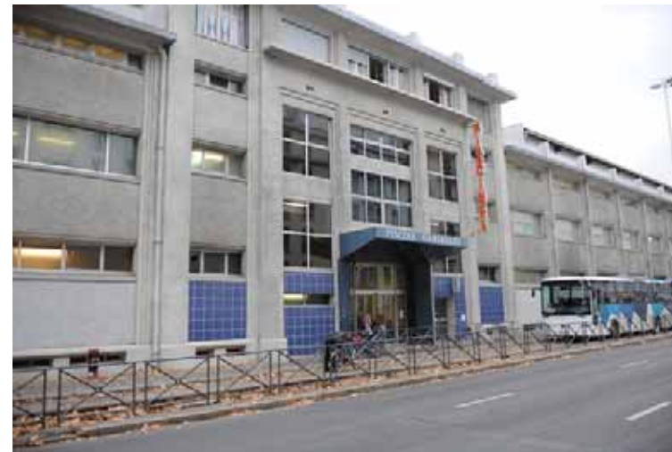
Lyon 3 e , accès piscine Garibaldi
