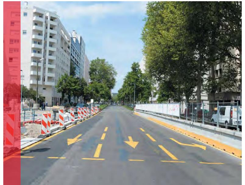
La réfection de l'axe central, destiné à accueillir les trois voies automobiles, est en cours d'achèvement. La circulation automobile, qui empruntait les voies extérieures de la rue Garibaldi, va progressivement être ramenée sur ces voies centrales et son emplacement définitif.
