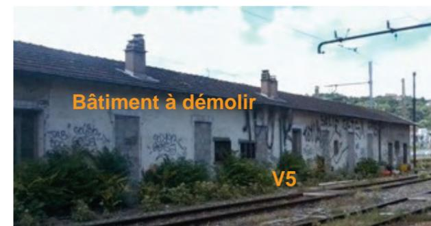
Afin de garantir la sécurité des circulations, la démolition du bâtiment sera réalisée en l'absence de circulation sur les voies 2, 5, 7, et 9. Afin de faciliter l'évacuation des matériaux, les voies 5, 7, 9 et les caténaires associées seront préalablement déposées.
