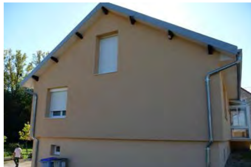
Une maison isolée par l'extérieur. Le raccordement avec le sol n'est jamais simple à exécuter.
