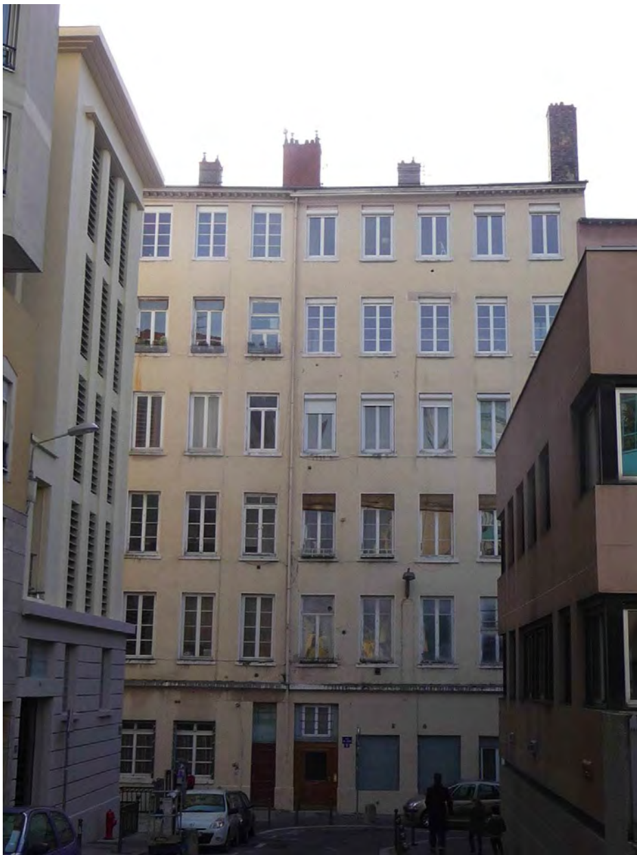
L'immeuble ayant servi d'objet d'étude, au 8 rue Général de Sève.
