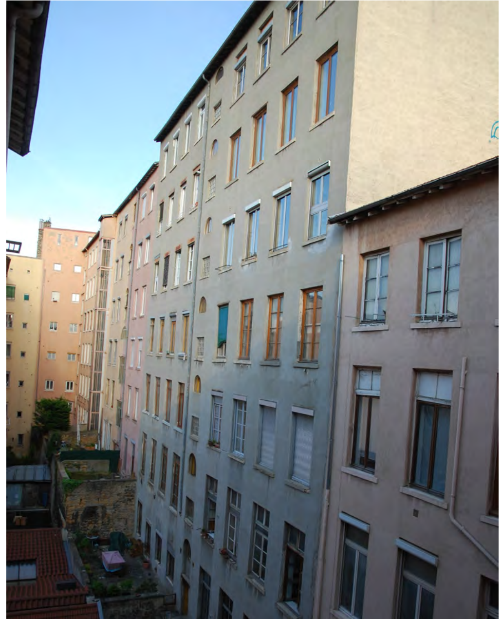
Façade arrière de l'immeuble étudié.
