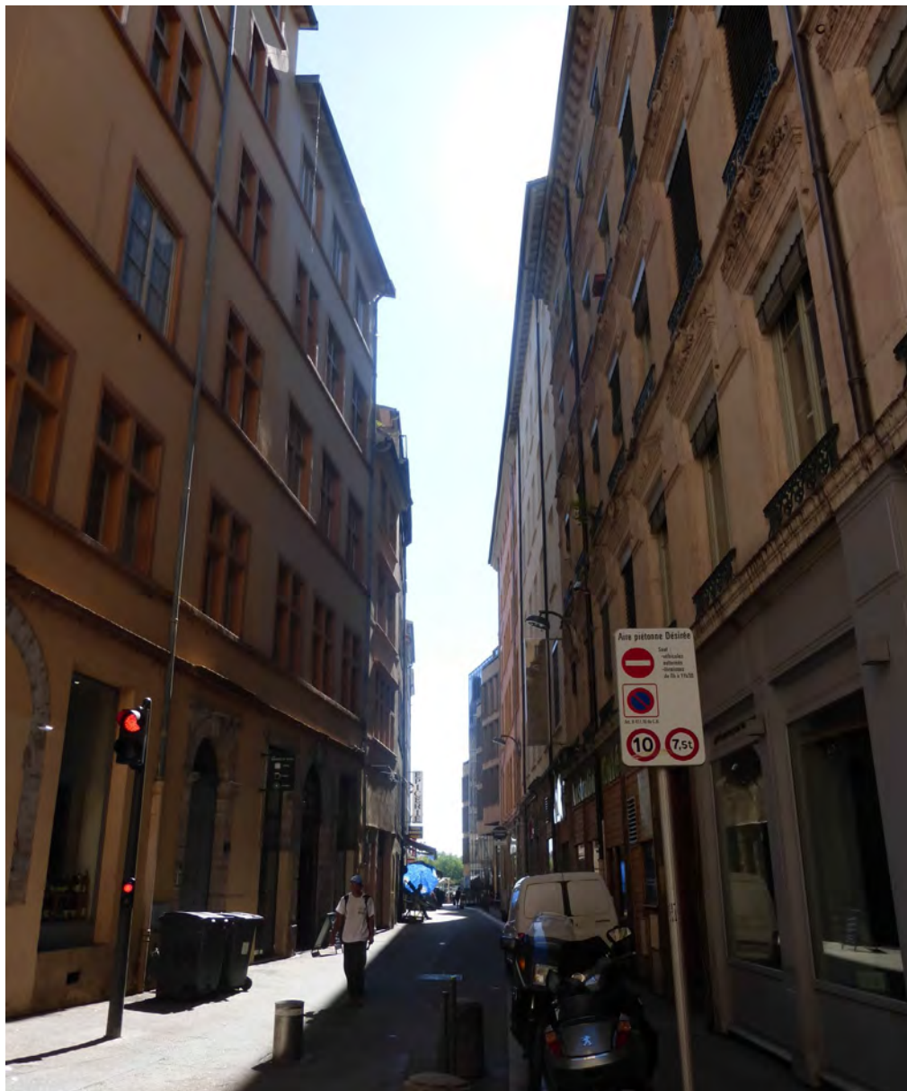
La rue Désirée, d'origine médiévale, dont une partie a été démolie dans les années 80.
