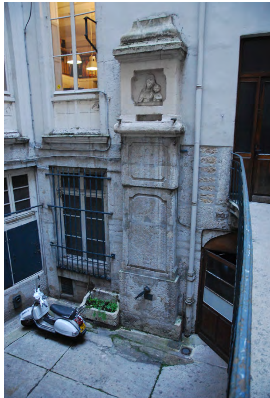
Une fontaine monumentale, installée dans la cour d'un immeuble du quartier Saint-Clair.
