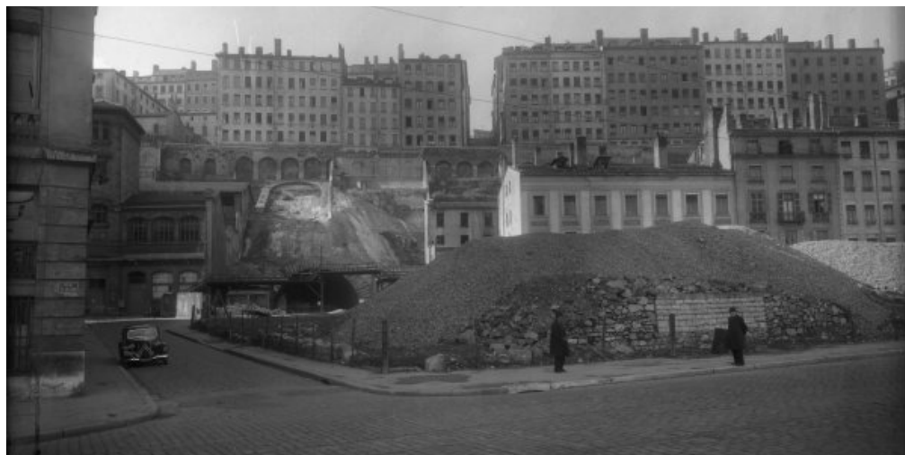
Construction du Tunnel de la Croix-Rousse, circa 1934, Jules Sylvestre. Bibliothèque municipale de Lyon / P0546 S 1420
