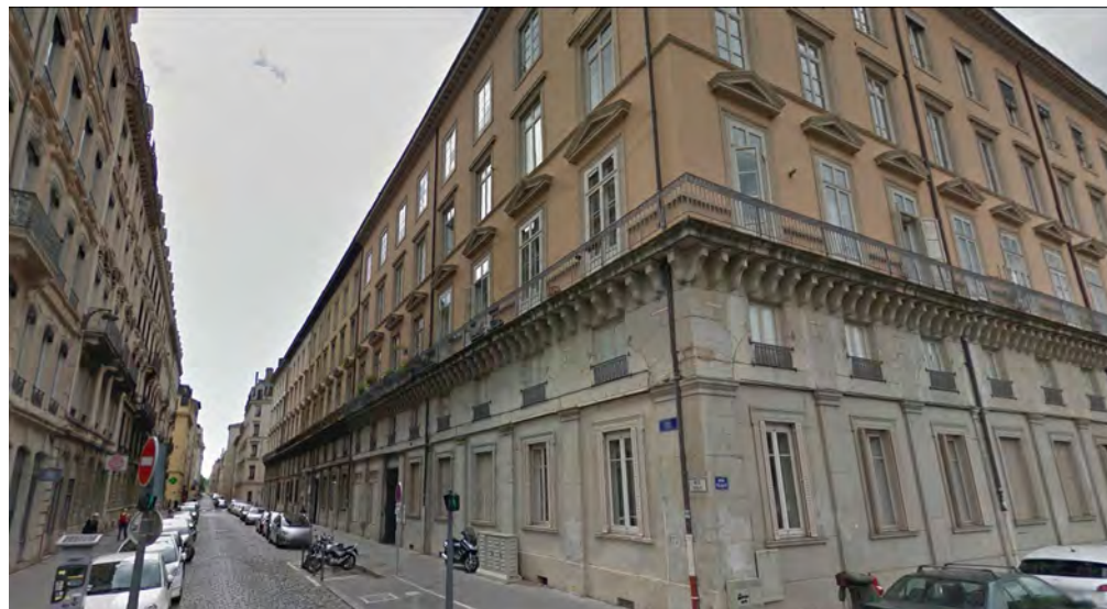
Un immeuble rue Sala, dans le 2nd arrondissement. C'est l'un des ensemble Empire les plus aboutis.
