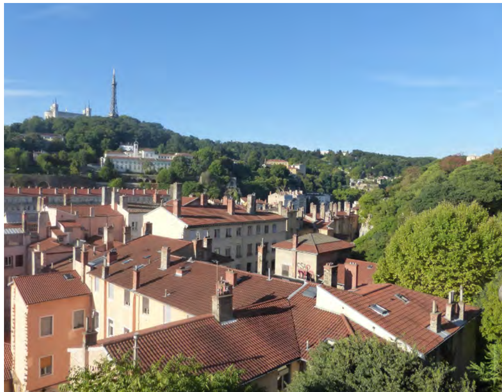
Le paysage des toitures lyonnaises est simple : tuiles terre cuite, toitures à double pans, cheminées. Il y a peu de lucarnes, sauf sur certains immeubles XIX e siècle.
