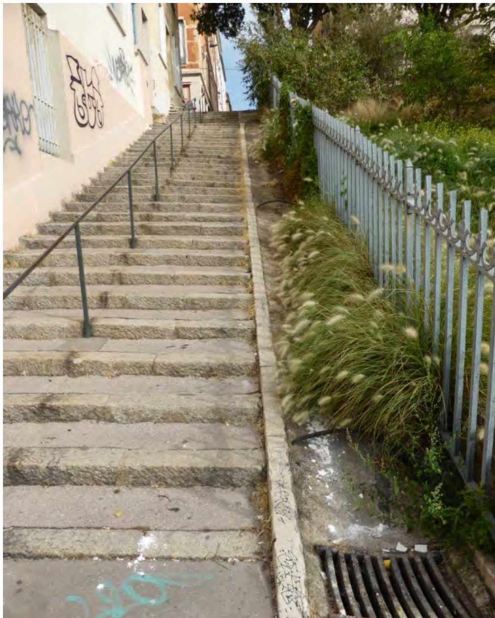
Escalier rue de Crimée. Photographie : Soberco Environnement
