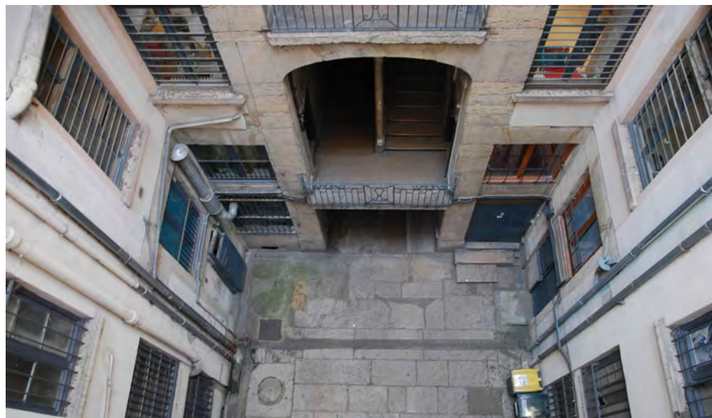
Portes Néoclassiques (vers 1760) et cour d'un immeuble de la rue Royale.
