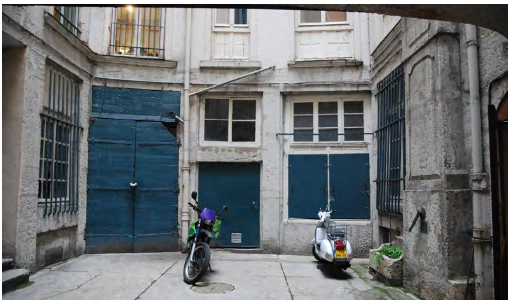
Escalier à la Lyonnaise, rambardes XVIII e et cour typique d'un immeuble de la rue royale : entresol, grandes dalles de pierre, citerne, pompe et fontaine, communs en rez-de-chaussée (écuries)...
