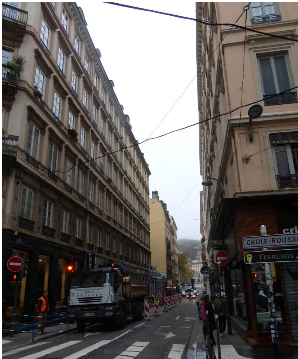
Les rues du XIX e siècle sont redressées et les façades des immeubles alignées.
