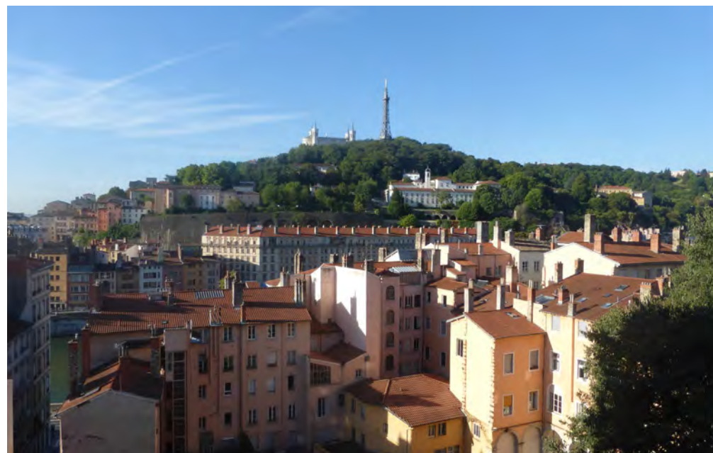
Les vues sur Lyon depuis les Pentes sont variées et omniprésentes.
