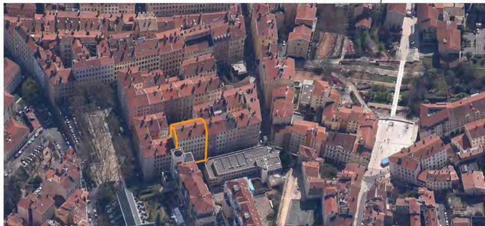
Vue depuis le Nord
