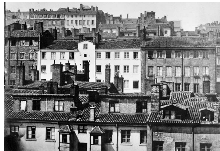
Façade arrière de n° pairs de la rue Burdeau. Notons les descentes de toilettes ! photographie F. Ambruster, 1869. Archives de Lyon - 3PH00467
