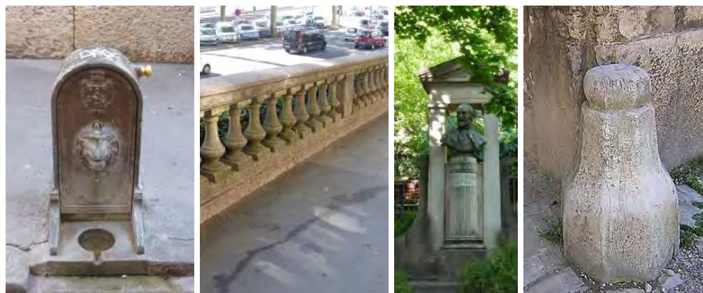
Les espaces extérieurs sont constitués d'une multitude de petits éléments fragiles, pouvant disparaître à l'occasion de réaménagements. Ils sont pourtant à conserver, car ils participent pleinement à la définition de l'identité des lieux.
