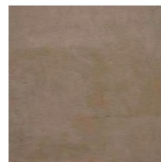
Enduit lissé à la truelle
