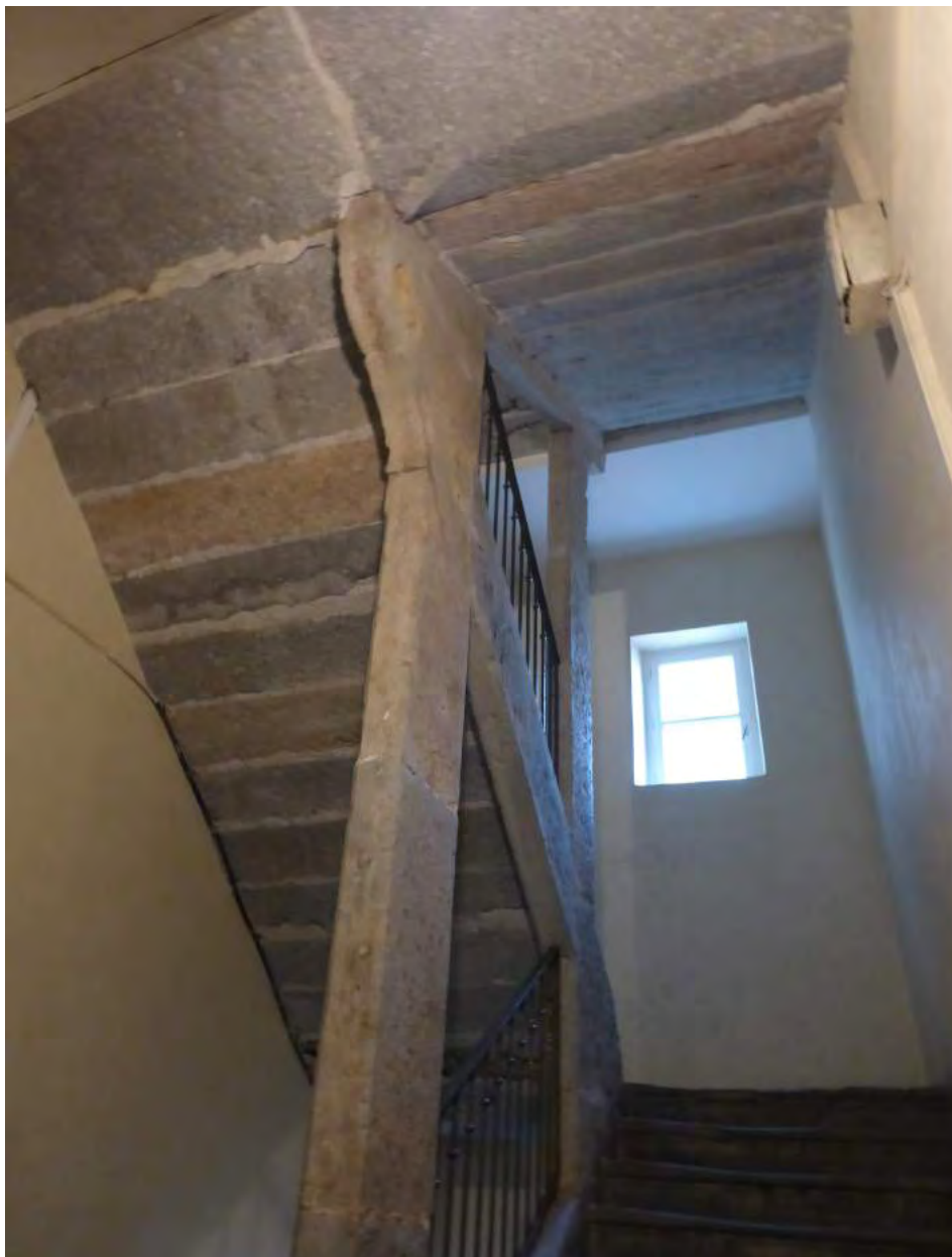
L'escalier du 28, rue Burdeau, beau représentant des murs porteurs ajourés, précédant les escaliers dits «à l'anglaise» développés massivement après 1840-1850.
