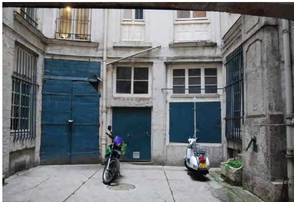
Une cour remarquable, rue Royale. Il est important d'encadrer les travaux de manière à conserver les qualités réelles de ces espaces : revêtements, intégration des équipements techniques, conservation des éléments de caractère (pompes, puits)...
