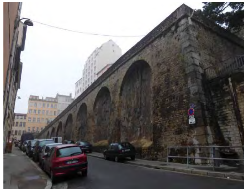
Les murs de soutènements sont omniprésents et particulièrement hétérogènes.
