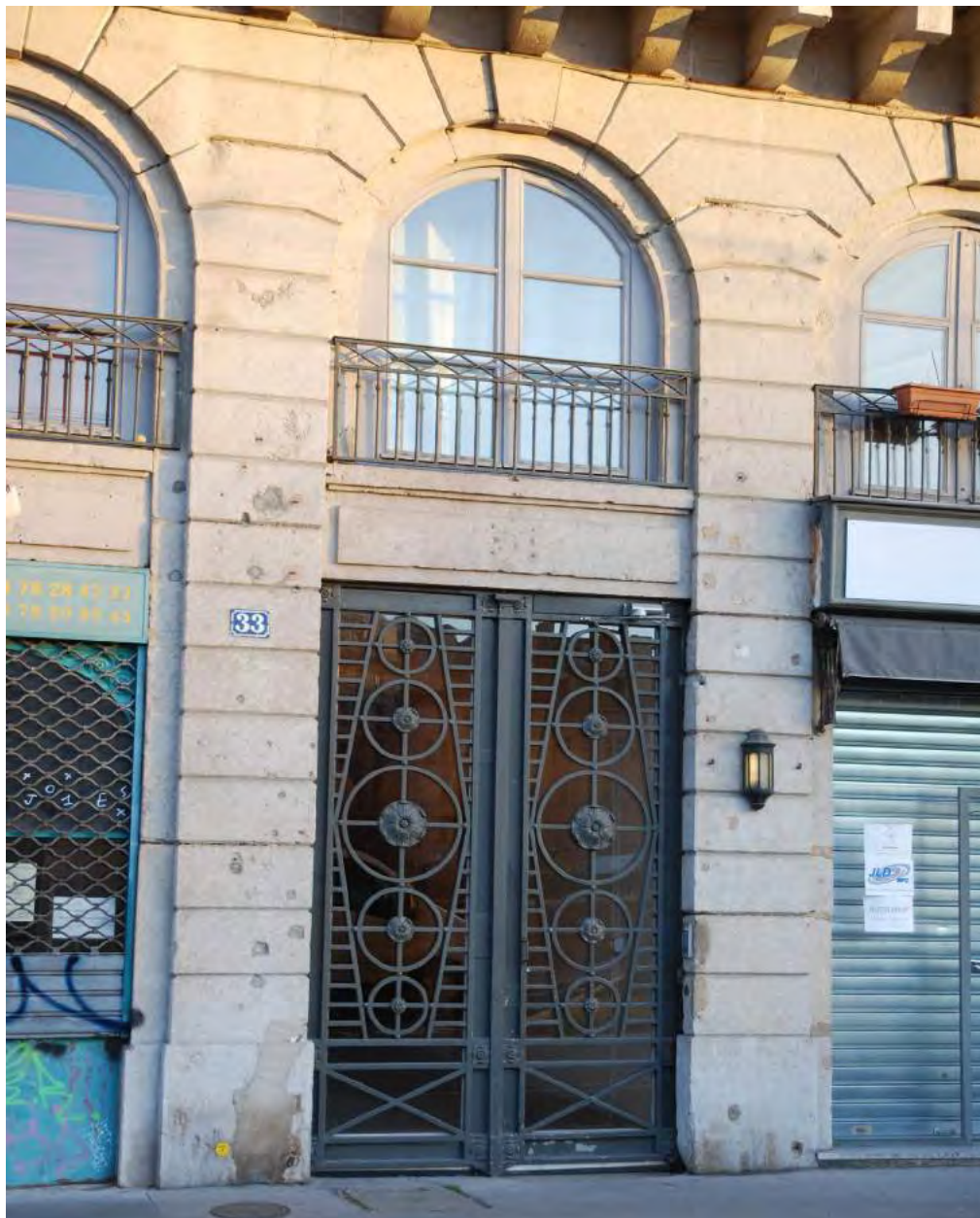
Les soubassements en pierre de Villebois sont omniprésents dans les constructions du XIX e siècle. Photographie Archipat.
