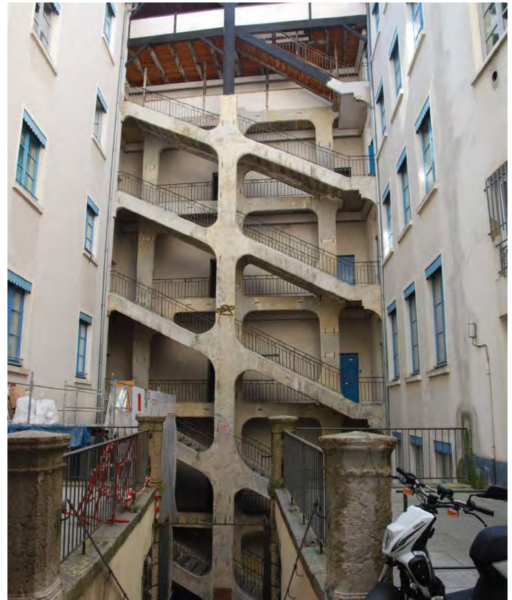
L'escalier de la cour des Voraces. Photographies Archipat.
