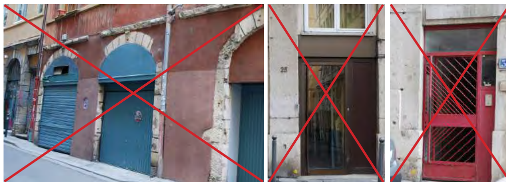
Les portes anciennes sont spécifiques à l'immeuble, les éléments remarquables doivent ainsi être conservés. Les nouvelles portes doivent être adaptées à l'encadrement dans lequel elles s'insèrent. La tole est interdite (garages).
