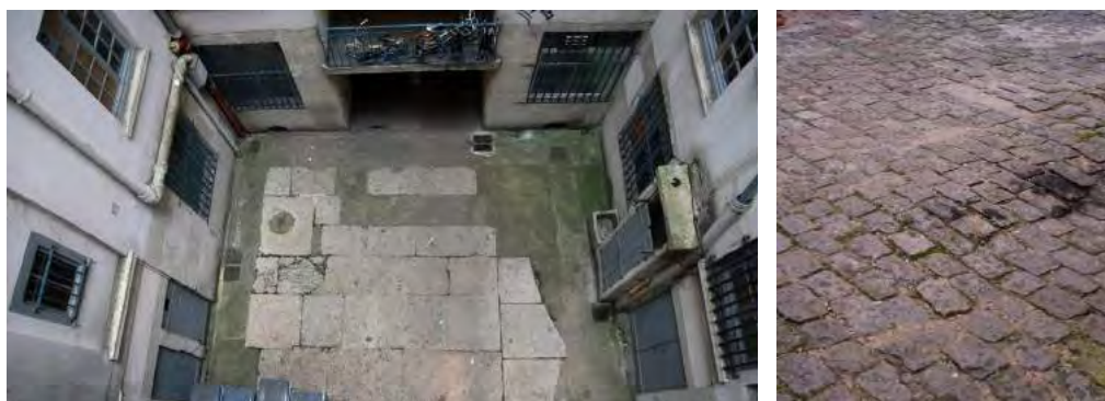
Quelques revêtements de sols traditionnels lyonnais, équipant rues, places et cours.
