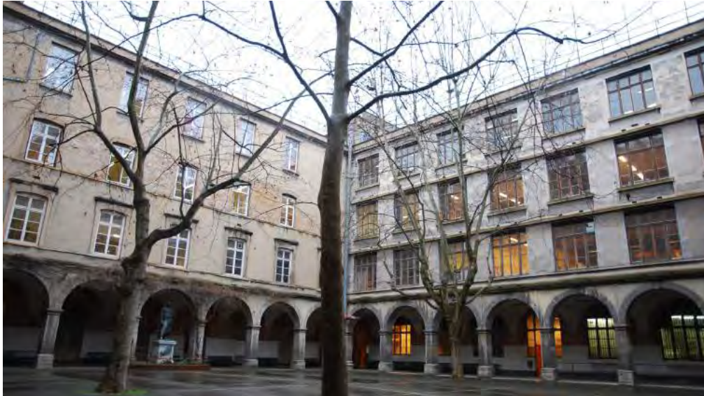
Couvent des Augustins, état actuel. Aujourd'hui Lycée technique de la Martinière. Photographies Archipat.
