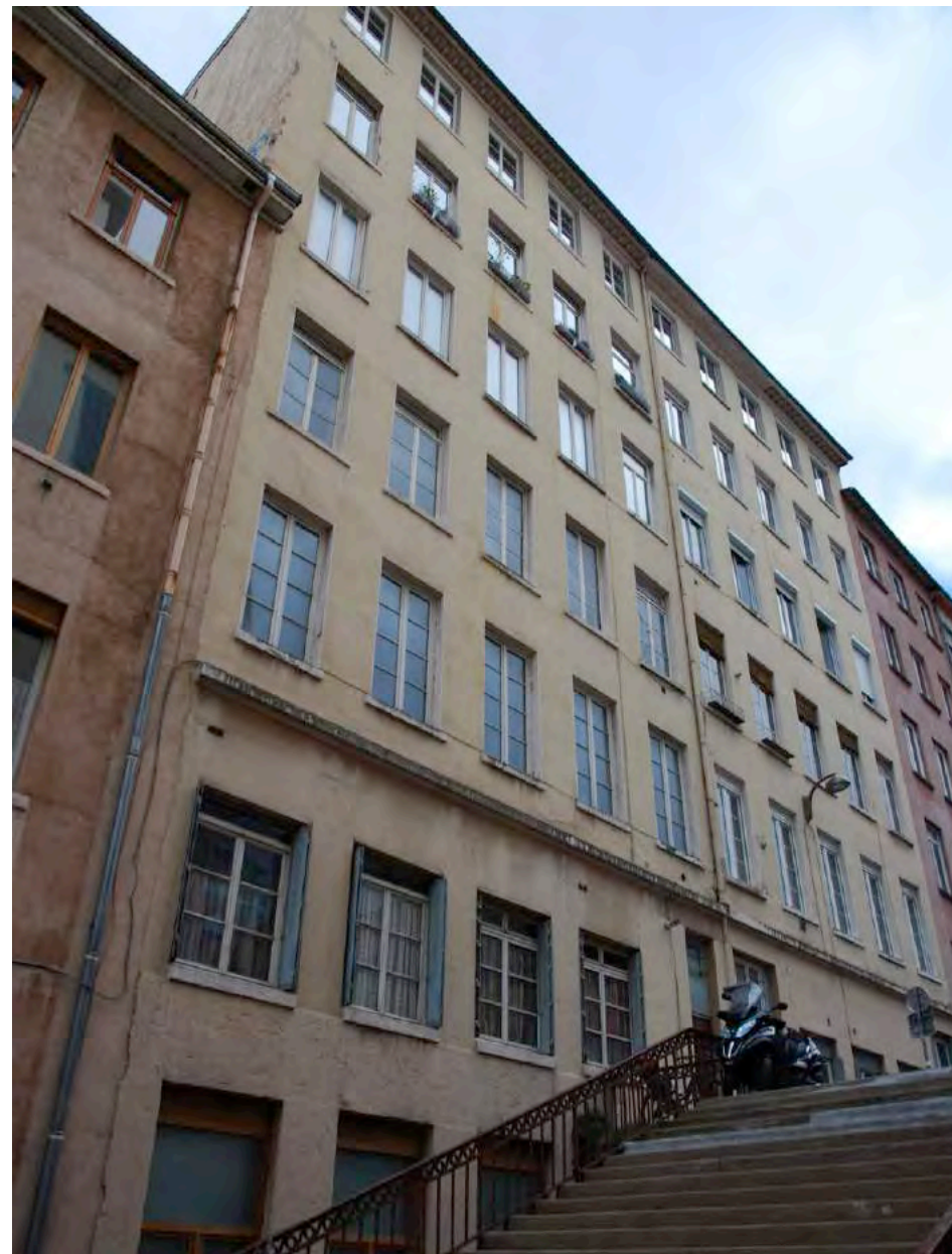
Façade sur rue du 8, rue Général de Sève.
