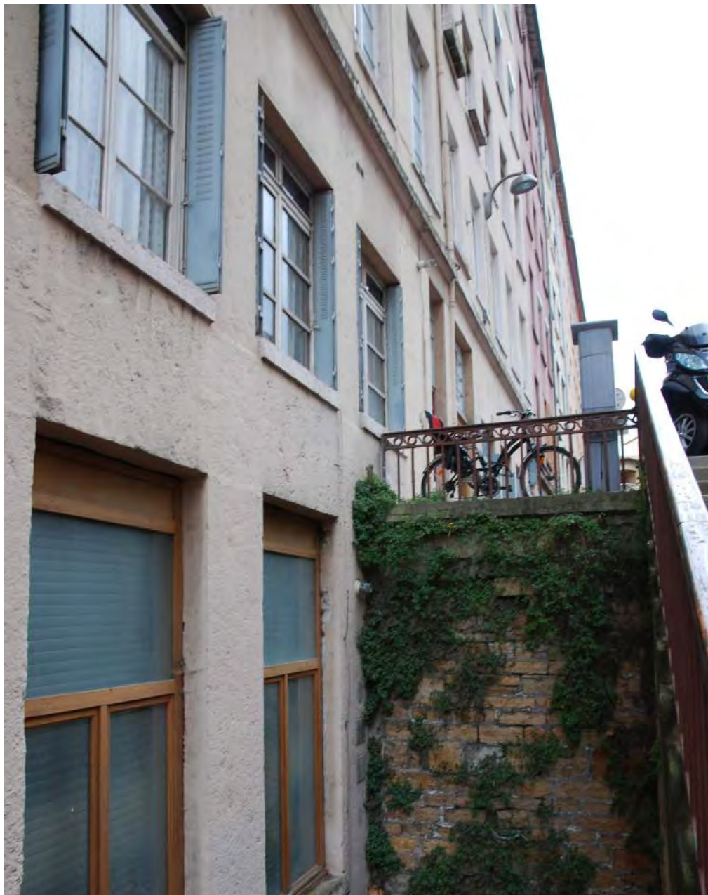
Une vue de la façade principale, l'appartement du sous-sol étant semi-enterré.
