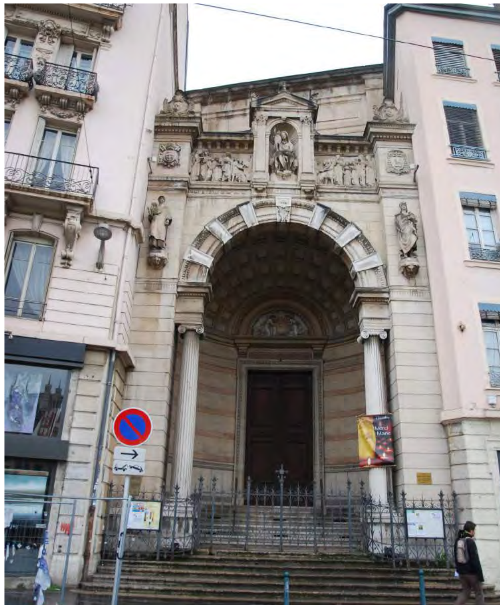
Portail de l'église Saint-Vincent, quai Saint-Vincent. Photographie Archipat.
