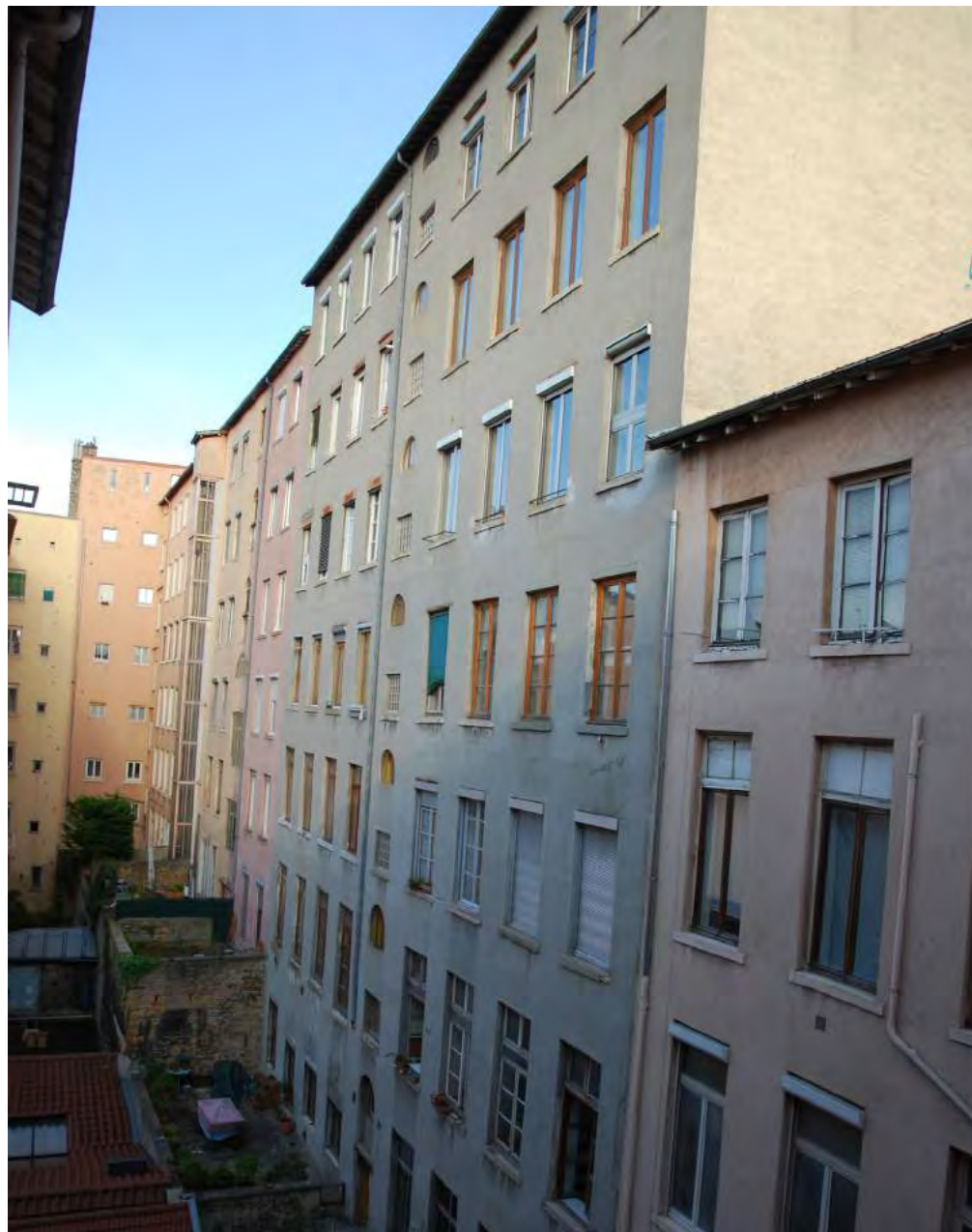
Façade arrière de l'immeuble étudié.
