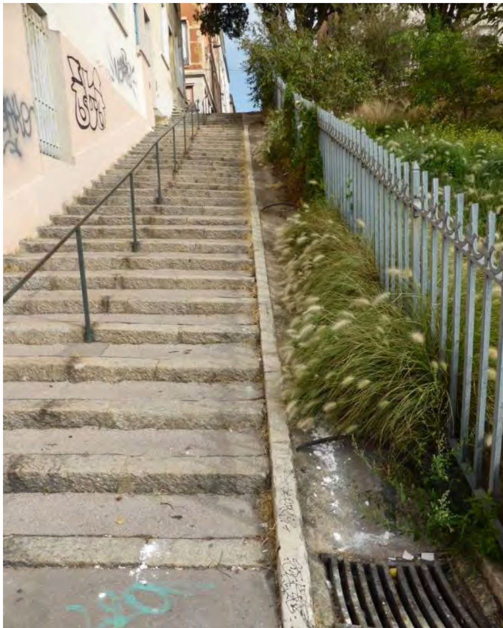
Escalier rue de Crimée. Photographie : Soberco Environnement
