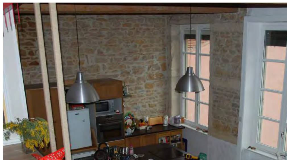
Poutres et murs en pierre apparente sont omniprésents dans ces immeubles. Toutefois, l'absence d'enduit favorise les infiltrations d'air froid et augmente la consommation énergétique.
