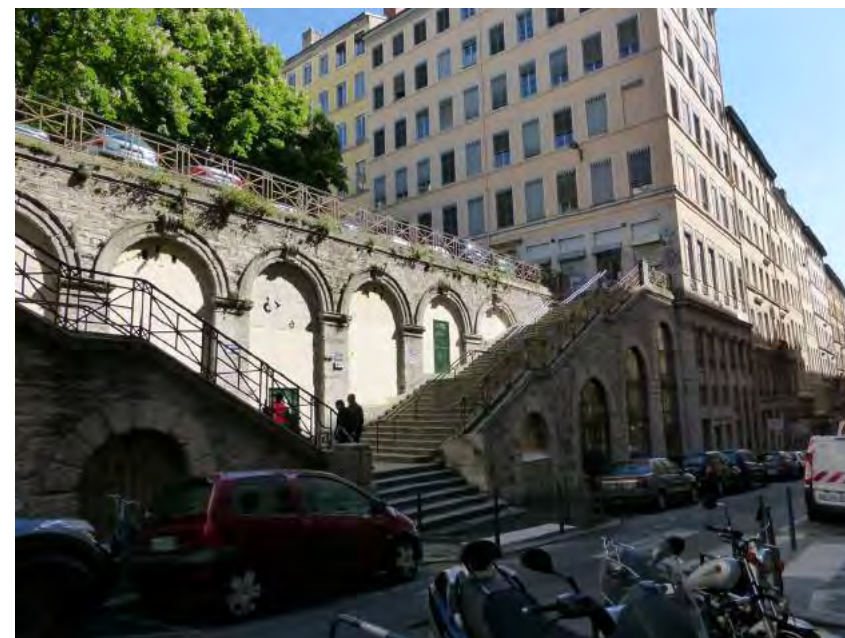
Ces monuments urbains sont parfois intégrés dans des compositions plus vastes. Ils en sont alors des éléments majeurs, comme dans le cas du passage Thiaffait.
