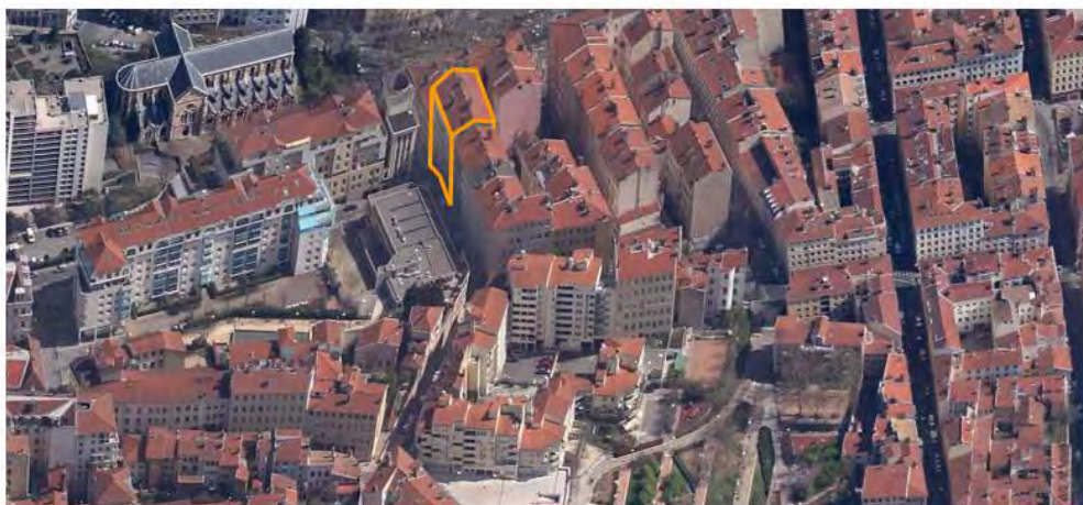
Vue depuis l'Ouest
