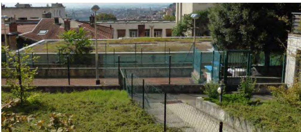
Construction contemporaine et toiture végétalisée, vue depuis la rue du Bon Pasteur. Photographies Soberco Environnement.
