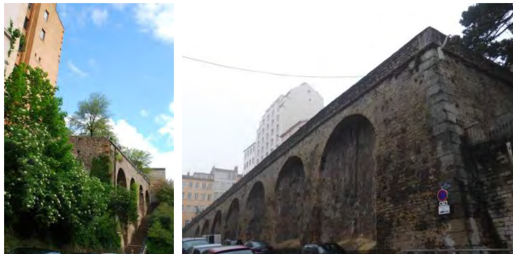
Les espaces publics des pentes - notamment les espaces urbains minéraux - doivent être traités dans un esprit de sobriété, utilisant une palette réduite de matériaux.
