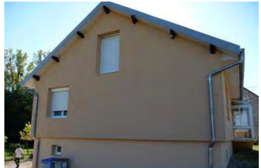
Une maison isolée par l'extérieur. Le raccordement avec le sol n'est jamais simple à exécuter.
