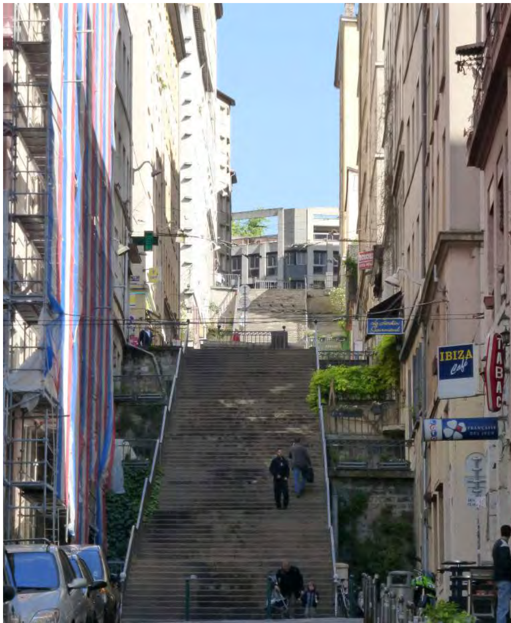
Certains alignements forment ce qui est communément appelé «des rues escalier». Ils soutiennent la colline et évitent les glissements de terrains.
