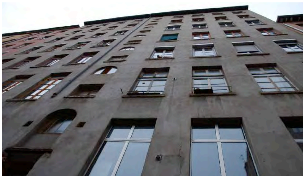
Façade sud de l'immeuble (en haut) En bas, vue depuis les logements situés au rez-de-chaussée, côté sud.
