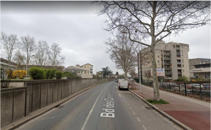
Photo de l'existant : boulevard des Canuts
