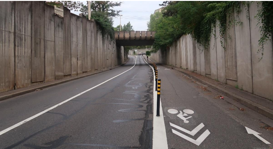
Photo de l'existant : Pont rue des Margnolles
