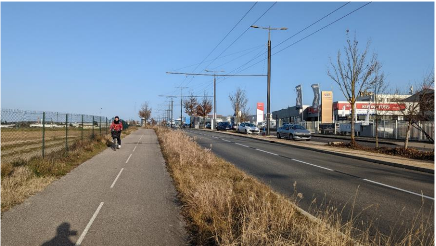
Photos de l'existant : Avenue Général Leclerc
