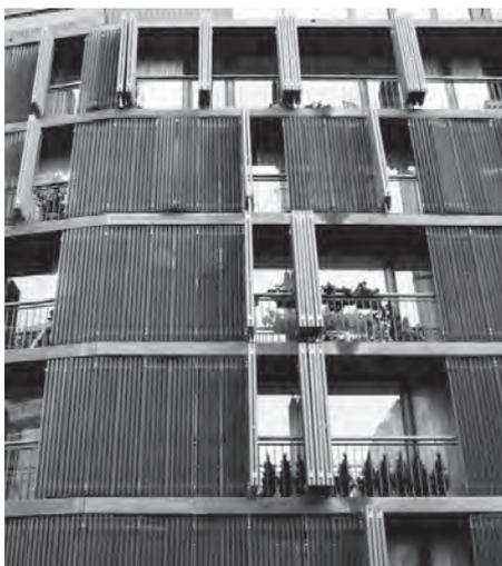
Volets ajourés à pantographe sur balcons
