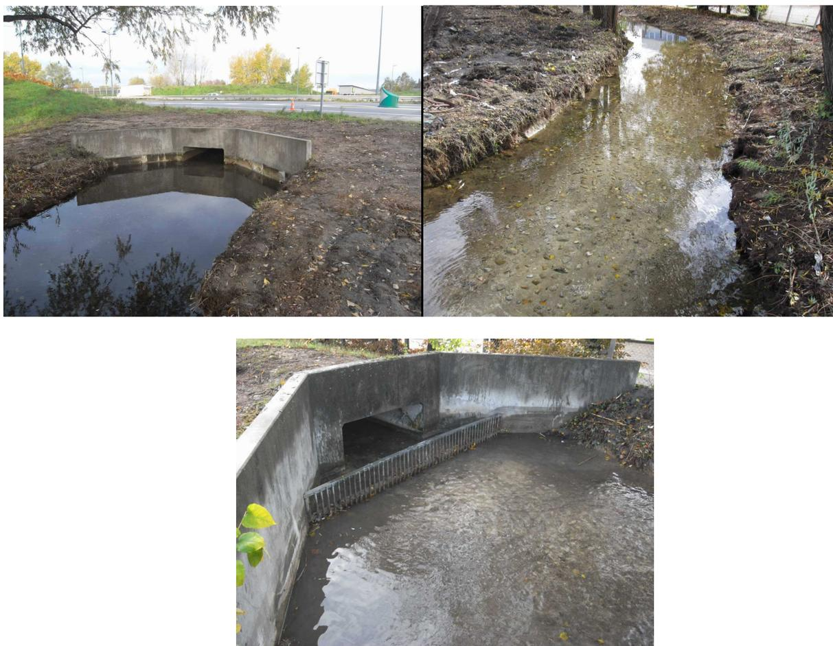
**Figure 9 : Photos du niveau d'eau et faible sédimentation en 2009 - source DIRCE**
