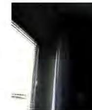
Les linteaux de menuiseries ne sont pas isolés ce qui entraîne des pertes d'énergie importantes sur l'ensemble des encadrements.
