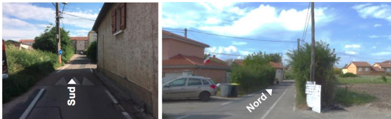
Figure 23 : Rue de Ponterle
