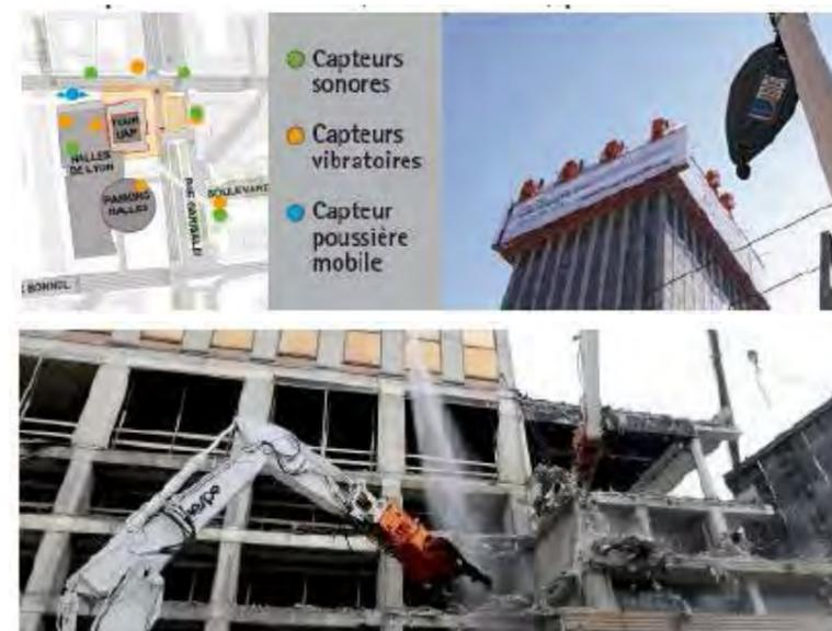
Figure 191 : Exemples de mesures mises en place dans le cadre du chantier de la Tour Incity : contrôle continu grâce à des capteurs (en haut), arrosage et micro-nébulisation pour limiter les poussières (en bas)
