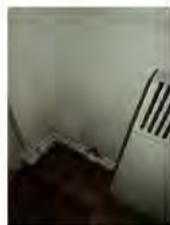
Comme décrit précédemment dans le rapport, il existe des grilles de ventilation dans les façades des logements du bâtiment du XVIII ce qui entraîne évidemment des pertes d'énergie. Cela dégrade également de manière importante le confort intérieur.
