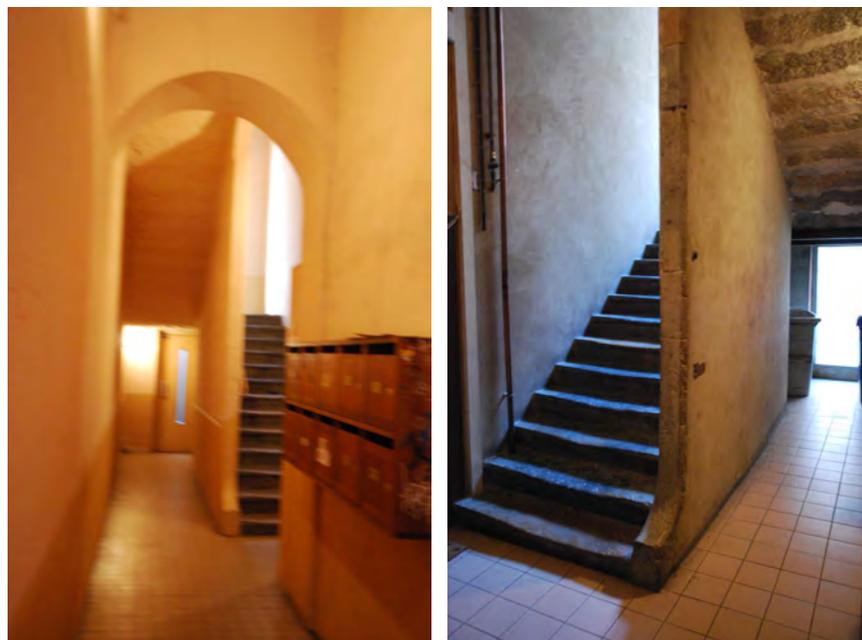
Quelques escaliers : en vis, avec ou sans noyau, à mur-noyau plein. Ce sont des typologies simples.
