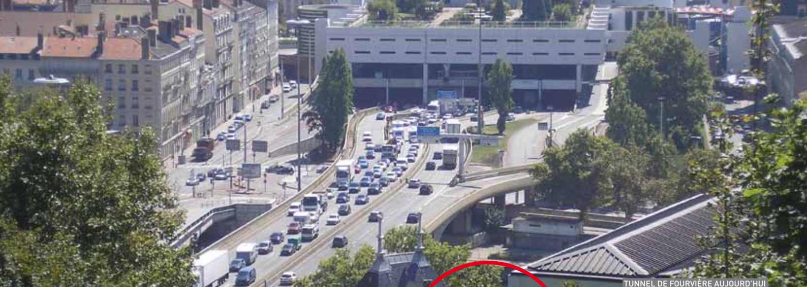
TUNNEL DE FOURVIÈRE AUJOURD'HUI
