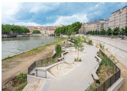
Chantier de la terrasse intermédiaire - début juin 2025
