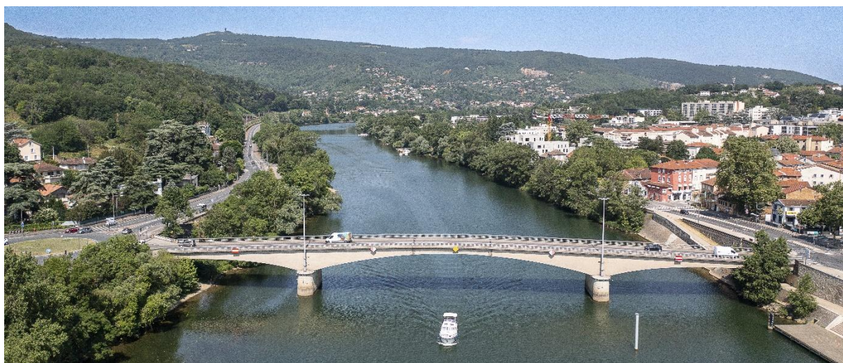
Le pont du Général Leclerc – @Métropole de Lyon
