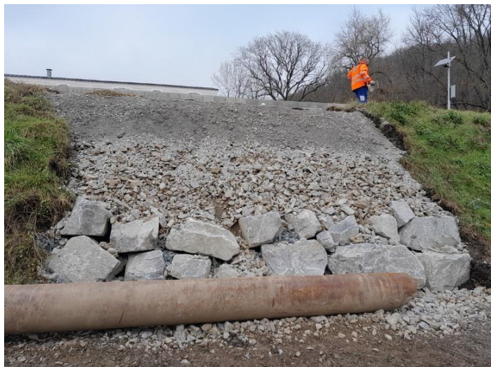
Réalisation de l'enrochement
