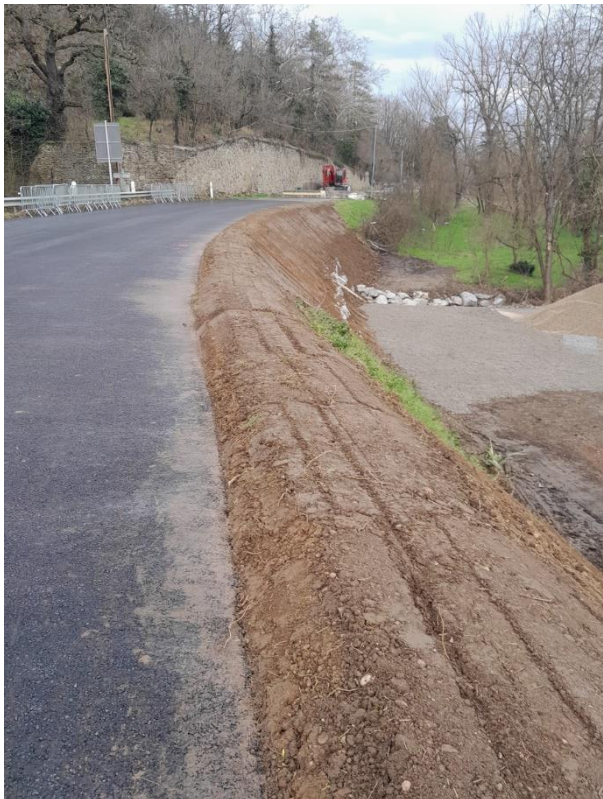
Fin des travaux sur la route de Rive de Gier, dans l'attente de la réalisation du marquage au sol
