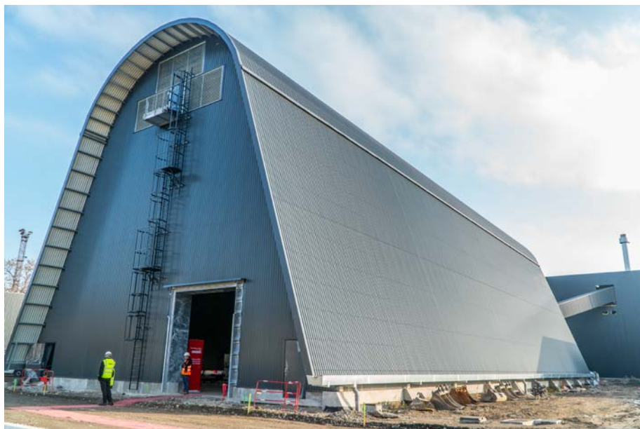
Le hall de stockage du bois servant à alimenter la chaufferie. Photo Hugo Rota (Métropole de Lyon)
