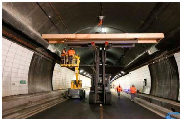
Pose de caisson sous la voûte du tunnel.
