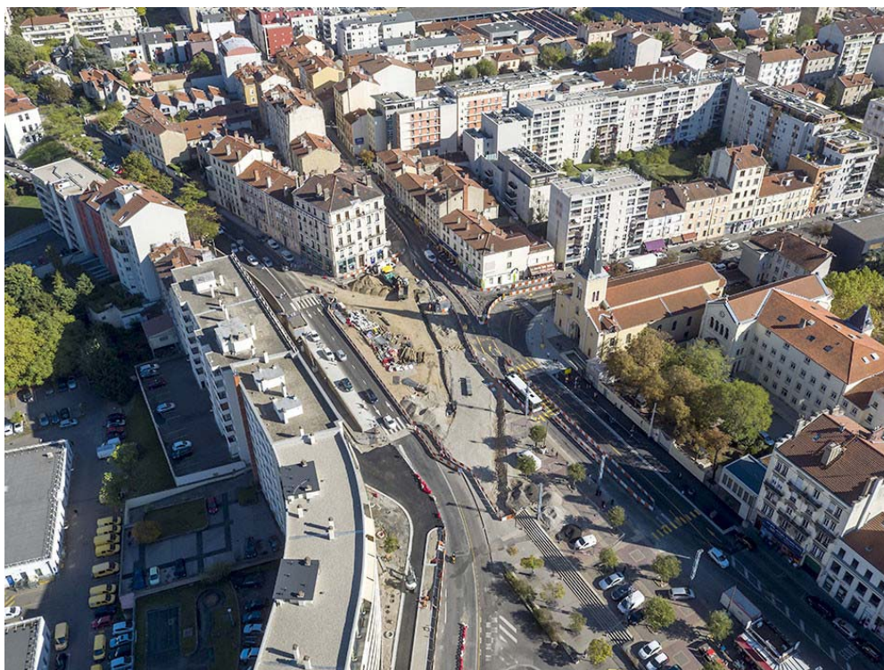
Le chantier actuel sur la place Grandclément.
