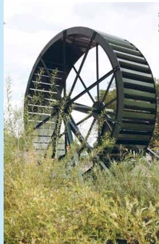
● Roue à aubes du moulin Berthier
