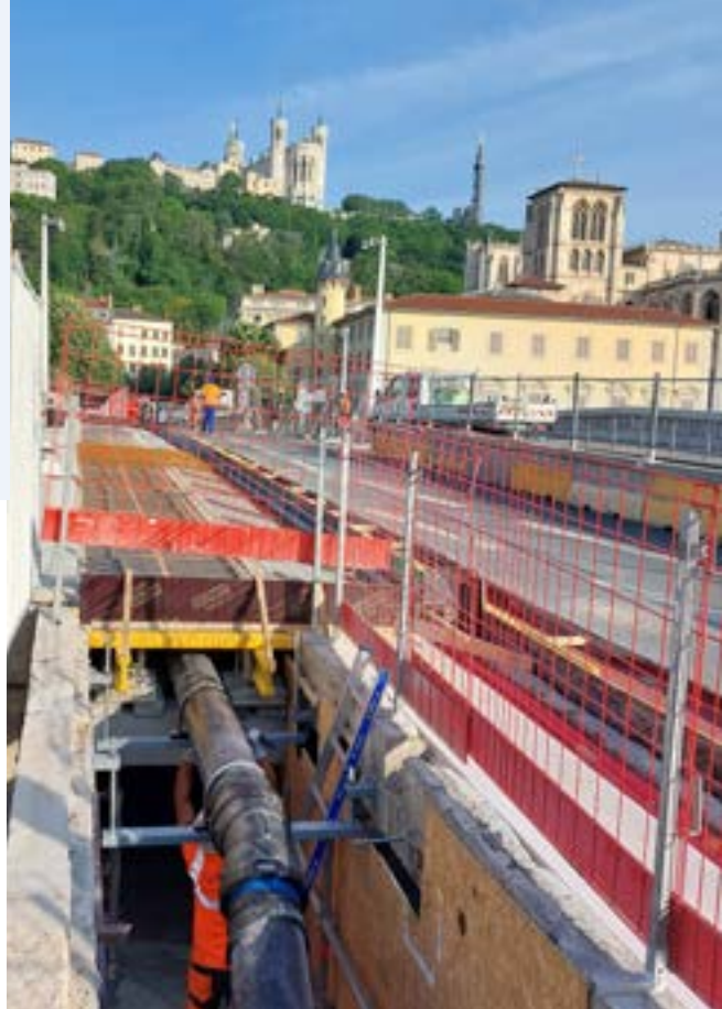
Renouvellement du réseau d'eau potable sur le pont Bonaparte à Lyon.
