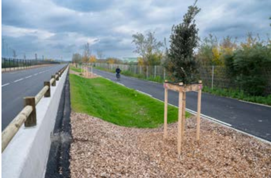
Noues le long d'une voie cyclable à Corbas.
