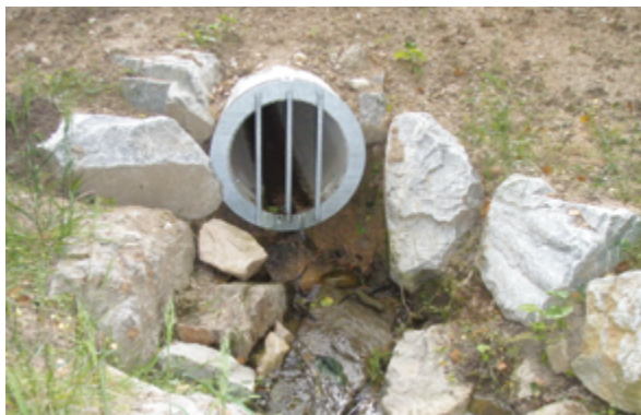
Grilles anti-intrusion et enrochement
