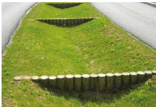
Noue enherbée avec cloison en bois
