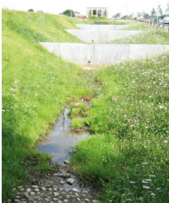
Noues avec cloison pour optimiser le stockage
