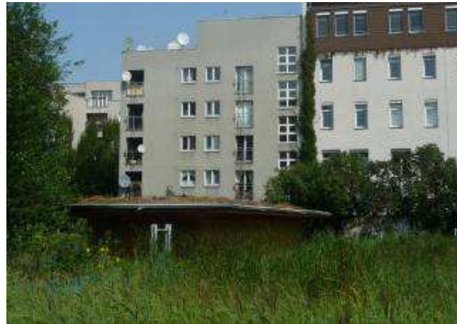
Fig.3 - Toiture Local technique Block 6 à Berlin, garage à Fribourg - Allemagne
