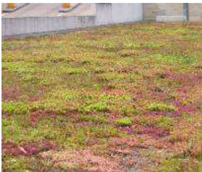
Fig.2 - Toiture parking parlement de Sarre – Allemagne
