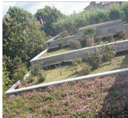
Fig.5 - Toiture gare de Perrache – Lyon / Fig. 5b Toiture Ste Foy
